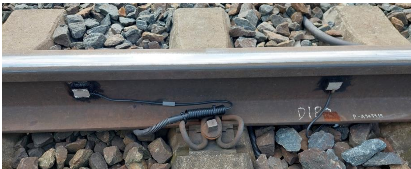
Obr. 8 Ověřovací provoz různých typů a konstrukcí snímačů.
