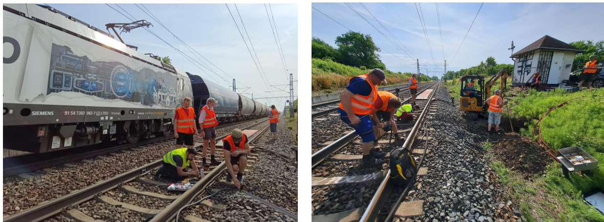
Obr. 5 Montáž zařízení DiPo na hlavní trati.
