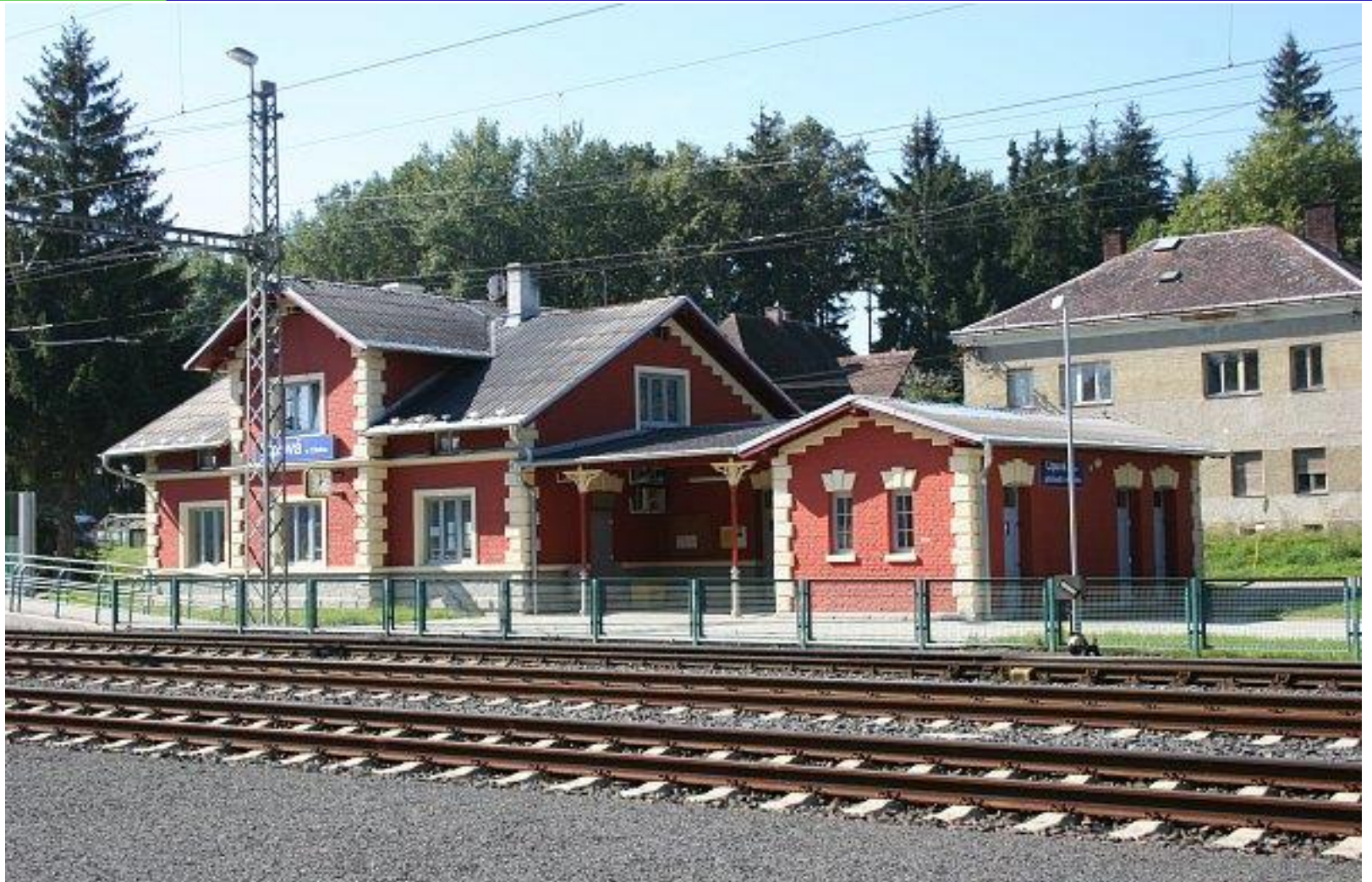
železniční stanice Lipová u Chebu
