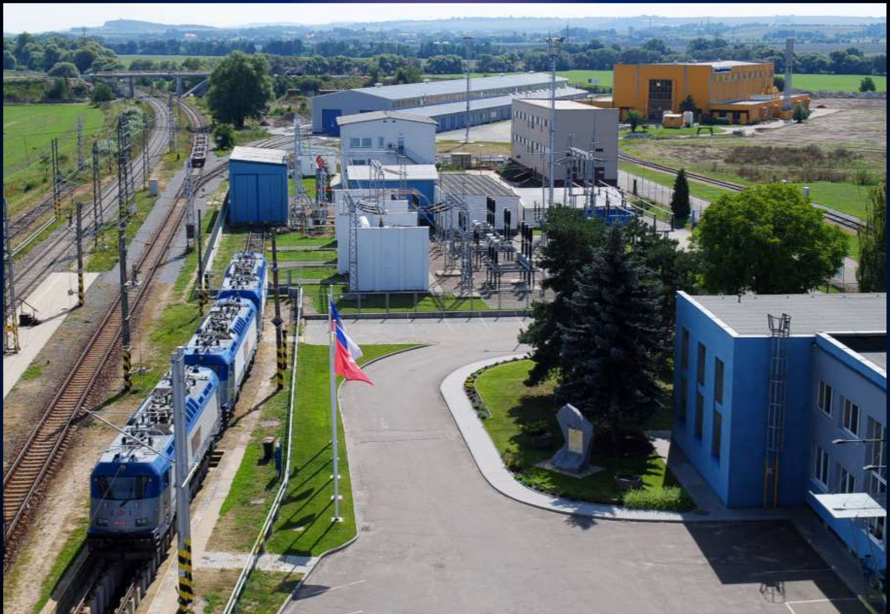
Pohled z osvětlovací věže ŽZO ve směru Kolín. Žlutá hala vpravo v pozadí je DZS, před ní napájecí stanice, vzadu uprostřed hala HPZ II prozatím s nedostavěnou koncovou částí. foto: 2012 propag. foto VUZ
