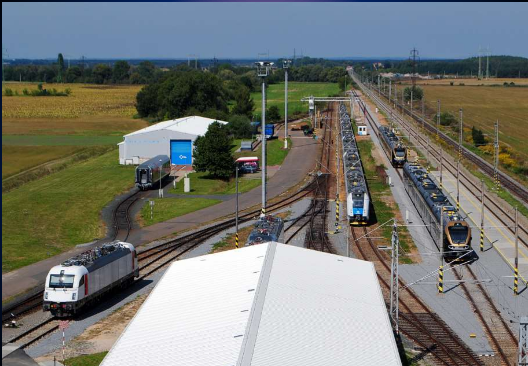
Pohled z osvětlovací věže ŽZO ve směru Praha (střecha v popředí patří hale HPZ III). Vlevo je ještě neprodloužená hala HPZ I, dobře viditelný je S-oblouk na koleji vedoucí do haly. foto: 2012 propag. foto VUZ
