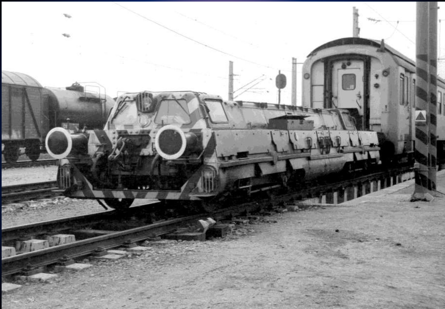
První motorovou posunovací „lokomotivou“ na ŽZO bylo speciální vozidlo „Milena“ T 450.001 (2x motor TATRA 301). Snímek je z doby, kdy ještě neexistoval MZO.
