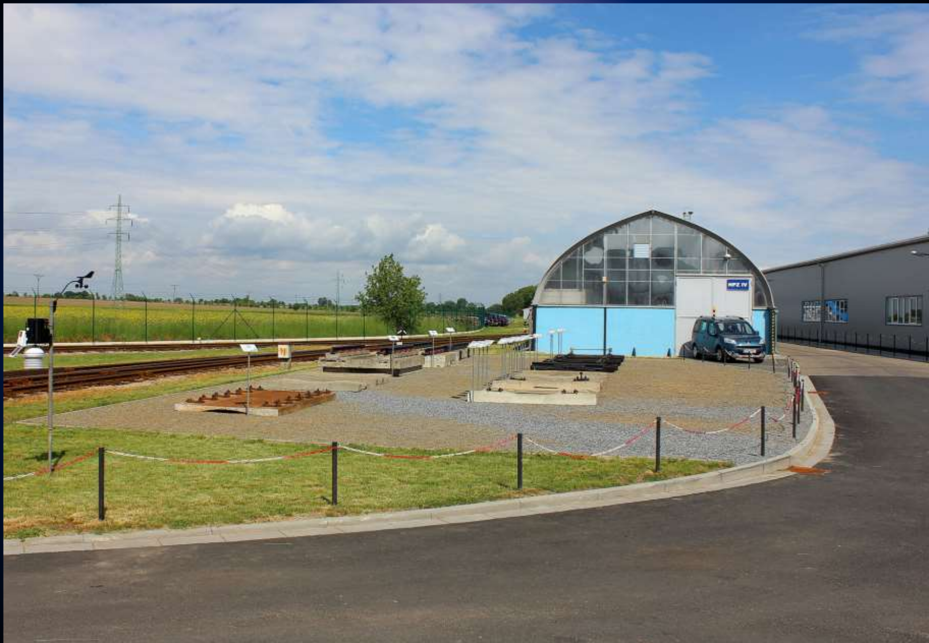
Výstavka různých typů kolejového svršku v prostoru mezi halou HPZ IV a hlavní administrativní budovou ZC. Větší část expozice pochází ze zkušebních úseků na MZO.
