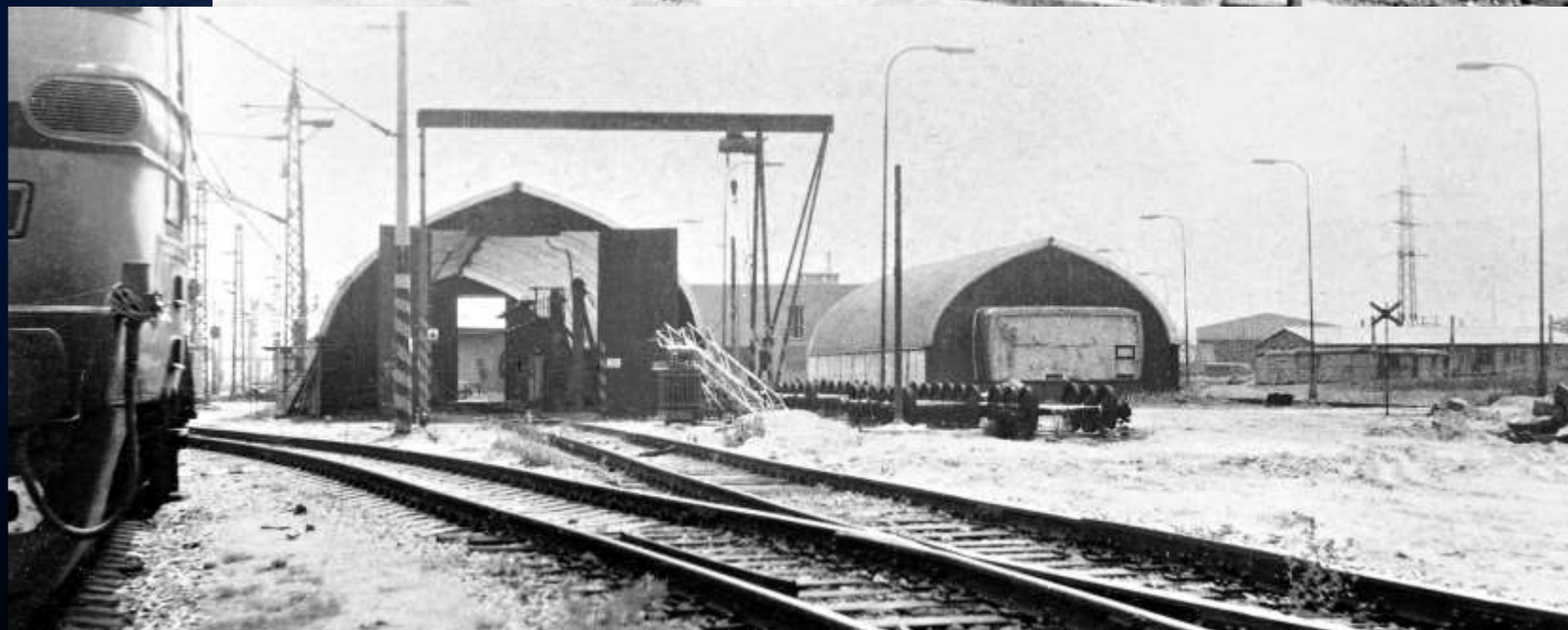
Čerstvě rozšířený areál zkušební základny ŽZO – pohled od VÚKV (nahore), resp. od 1. koleje (dole). Na místě otevřené laminátové haly a jeřábu dnes stojí hala HPZ III. sbírka R. Kolmačka
