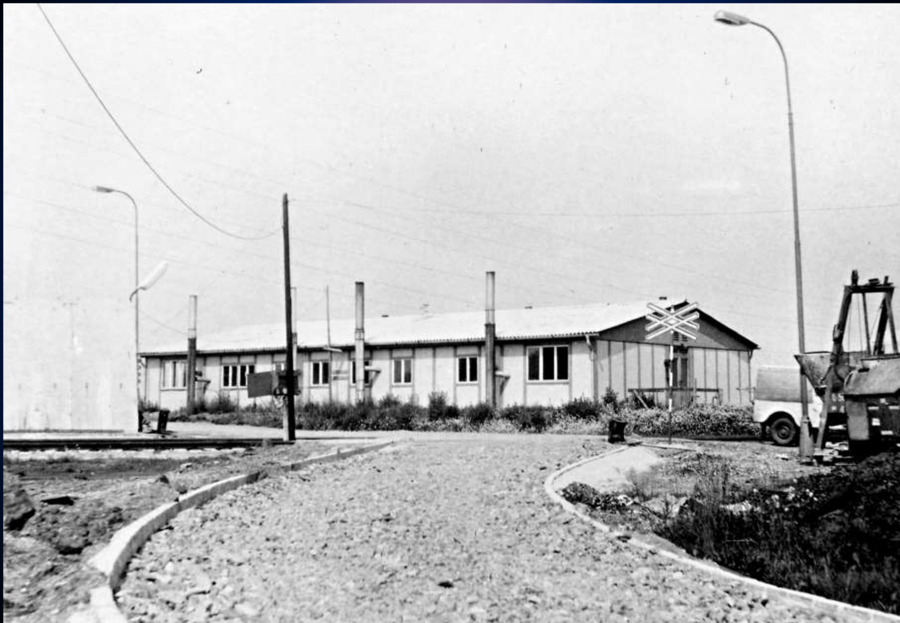
Budova se sklady VÚKV s vrátnicí do areálu v čelní části (nejdále od objektivu). Na stejném místě stojí dnešní vrátnice ŽZO.
