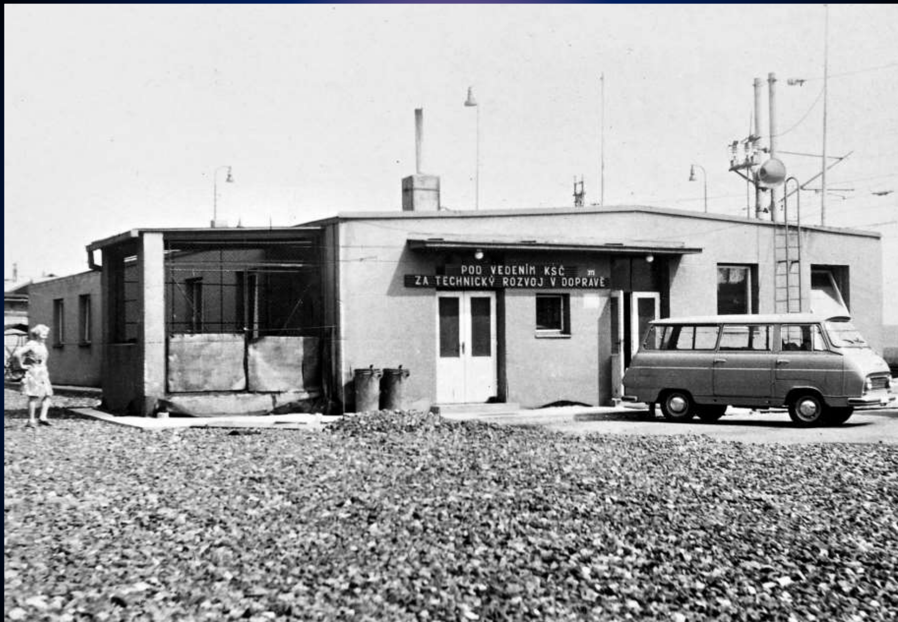
Malá provozní budova ŽZO – dodnes se příliš nezměnila...
