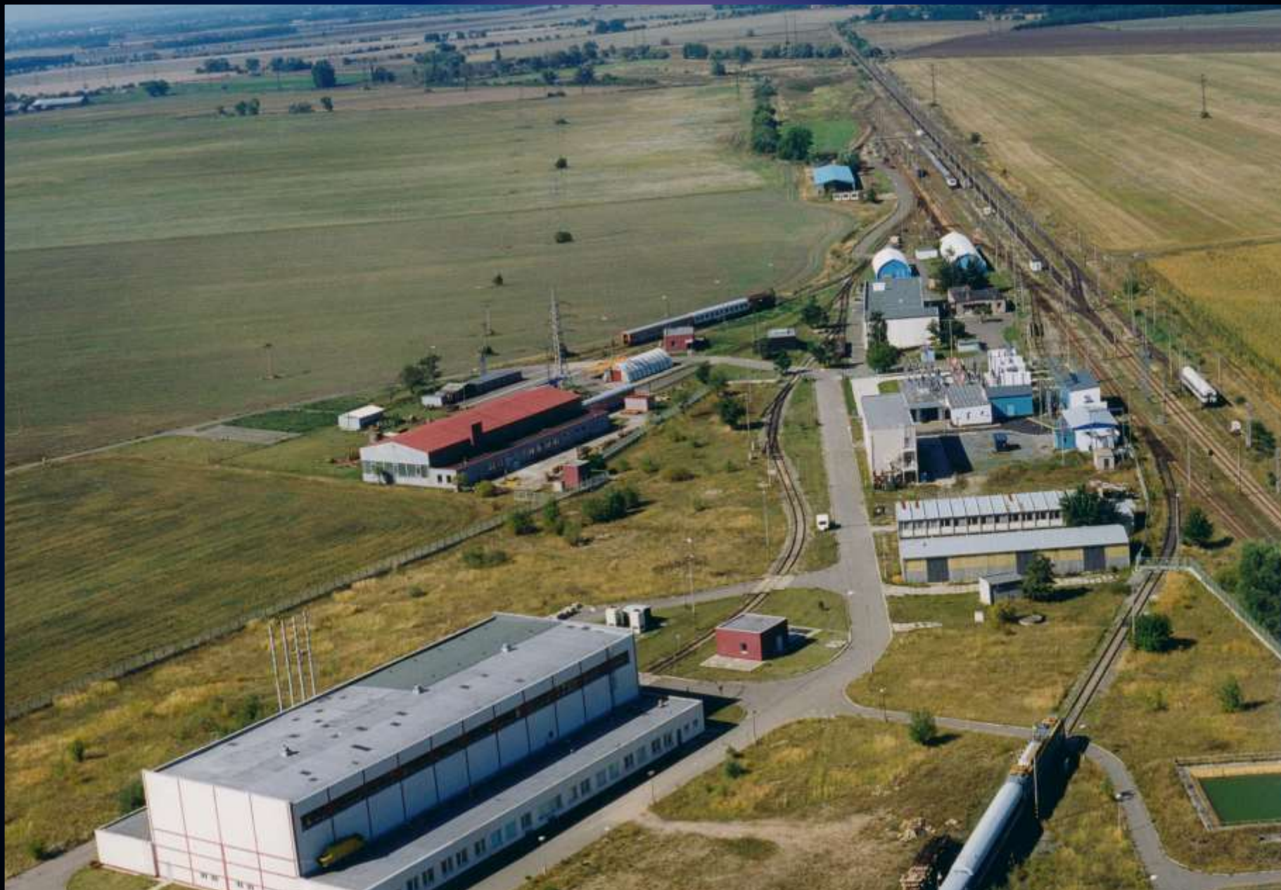
Letecký pohled na zkušební základnu na počátku 90. let. Na snímku je patrná kolej pro odstavování měřicích vozů, výhybky u měrného oblouku i přístřešek pro lokomotivy.
