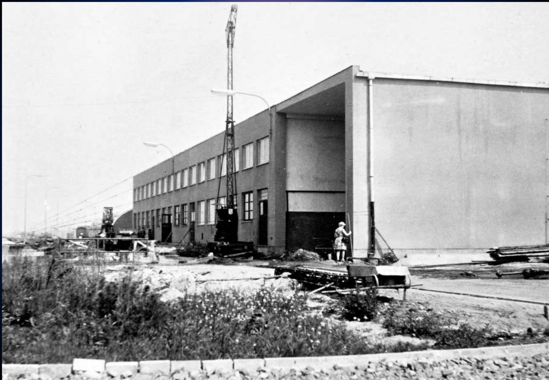
Stavba nové (současné) administrativní budovy ŽZO – pohled od VÚKV.
