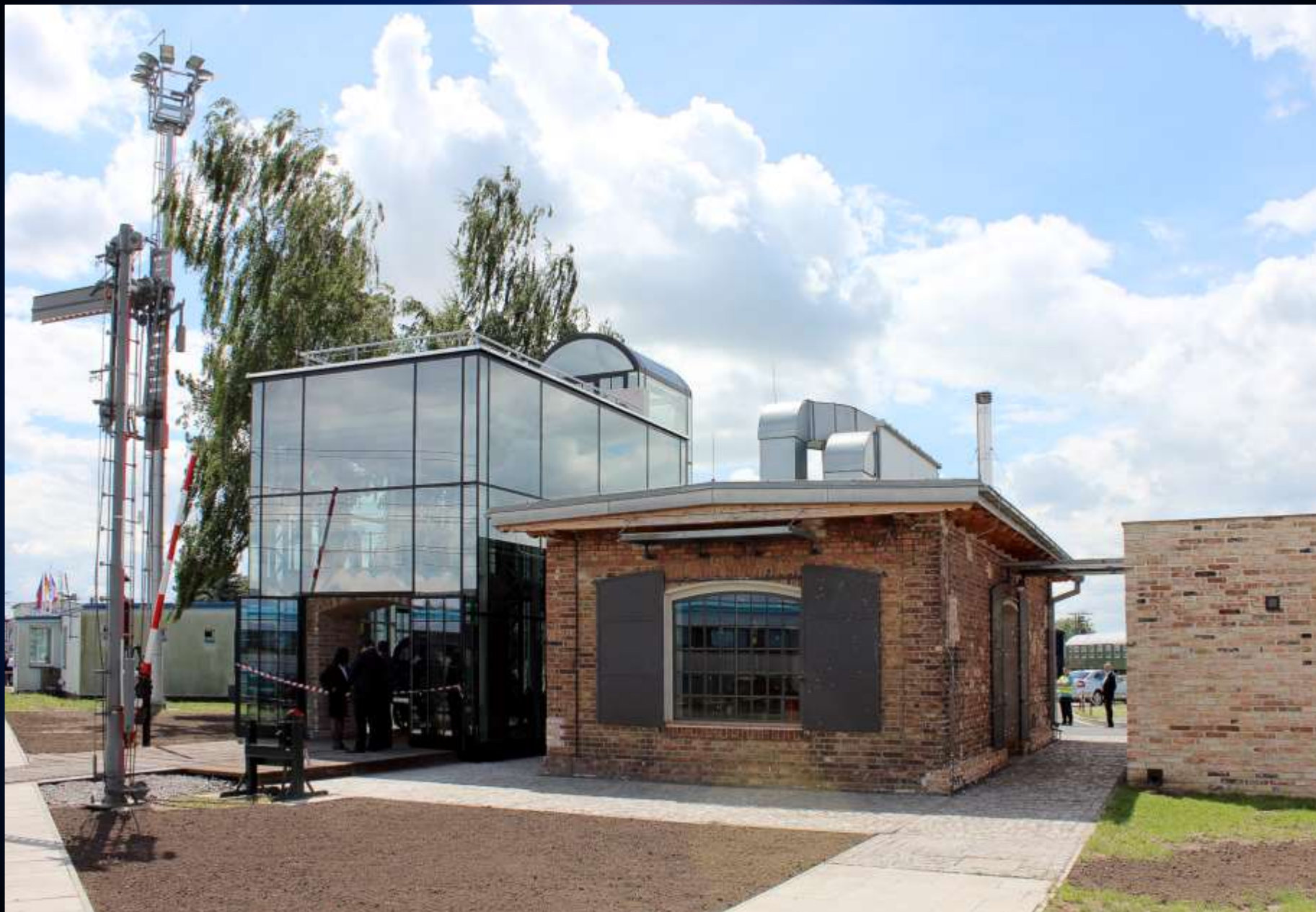
Pohled na nově vybudované marketingové objekty „stará kovárna“ a „rozhledna“ ze strany od kolejíště, úplně vlevo je patrná malá provozní budova s dopravní kanceláří.
