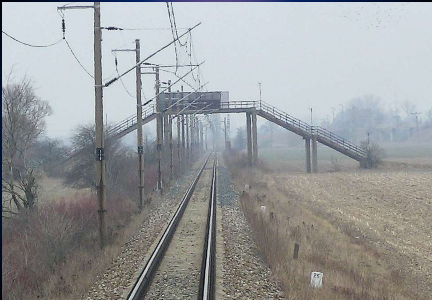
Lávka v km 7,9 na „zadní přímé“ velkého zkušebního okruhu při pohledu z lokomotivy foto: 2005 (doprava vede cesta do Sokolče, vlevo přes les k Osečku) v době těsně před snesením. sbírka R. Kolmačka
