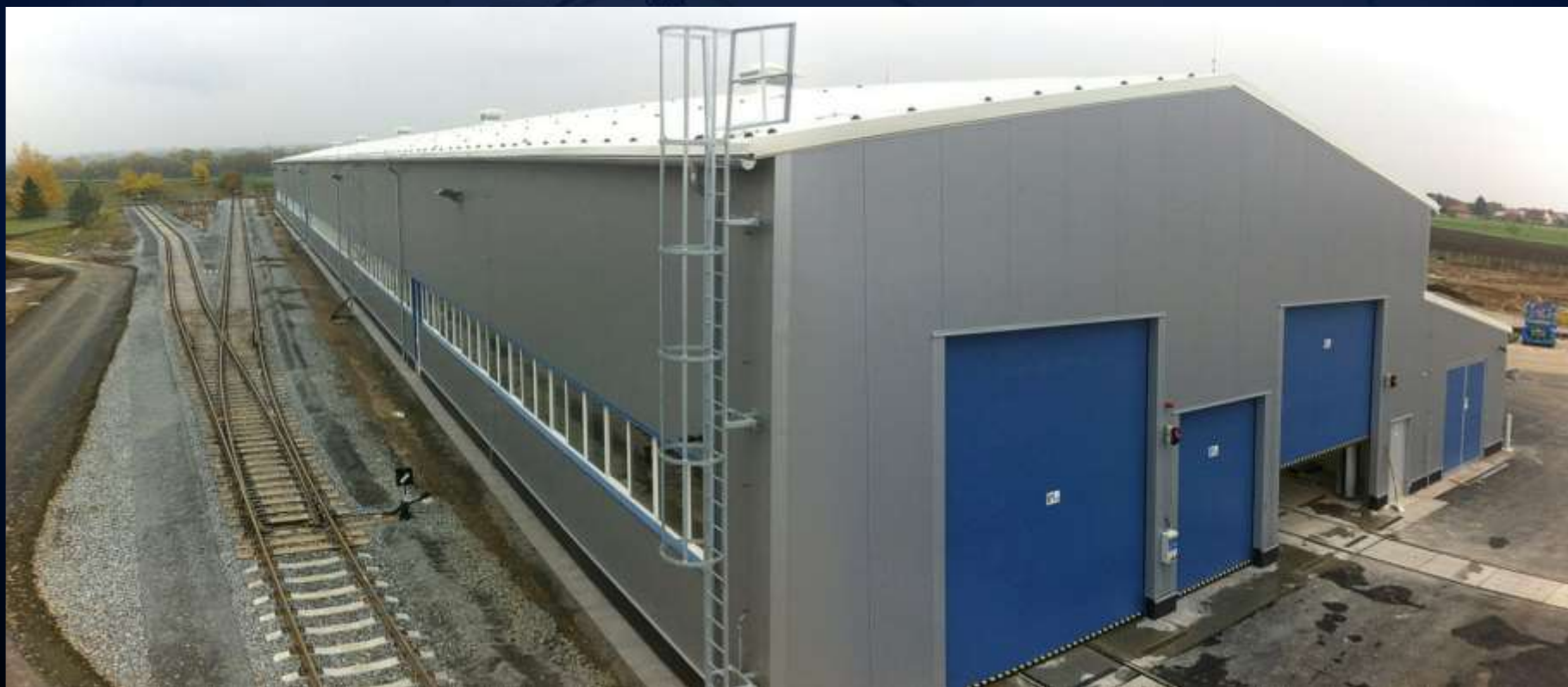
Hala HPZ II po první fázi výstavby – v pozadí silnice Sokoleč – Cerhenice.
