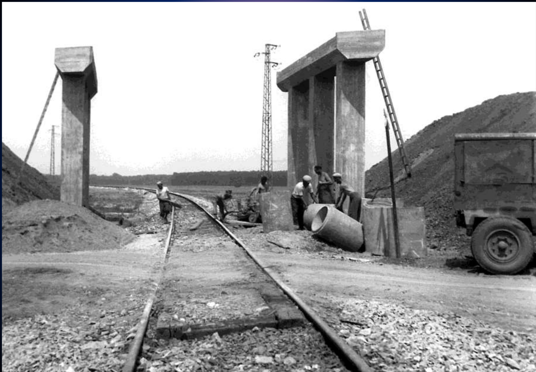
Stavba silničního nadjezdu v místě provizorního přejezdu silnice Sokoleč – Pňov.
