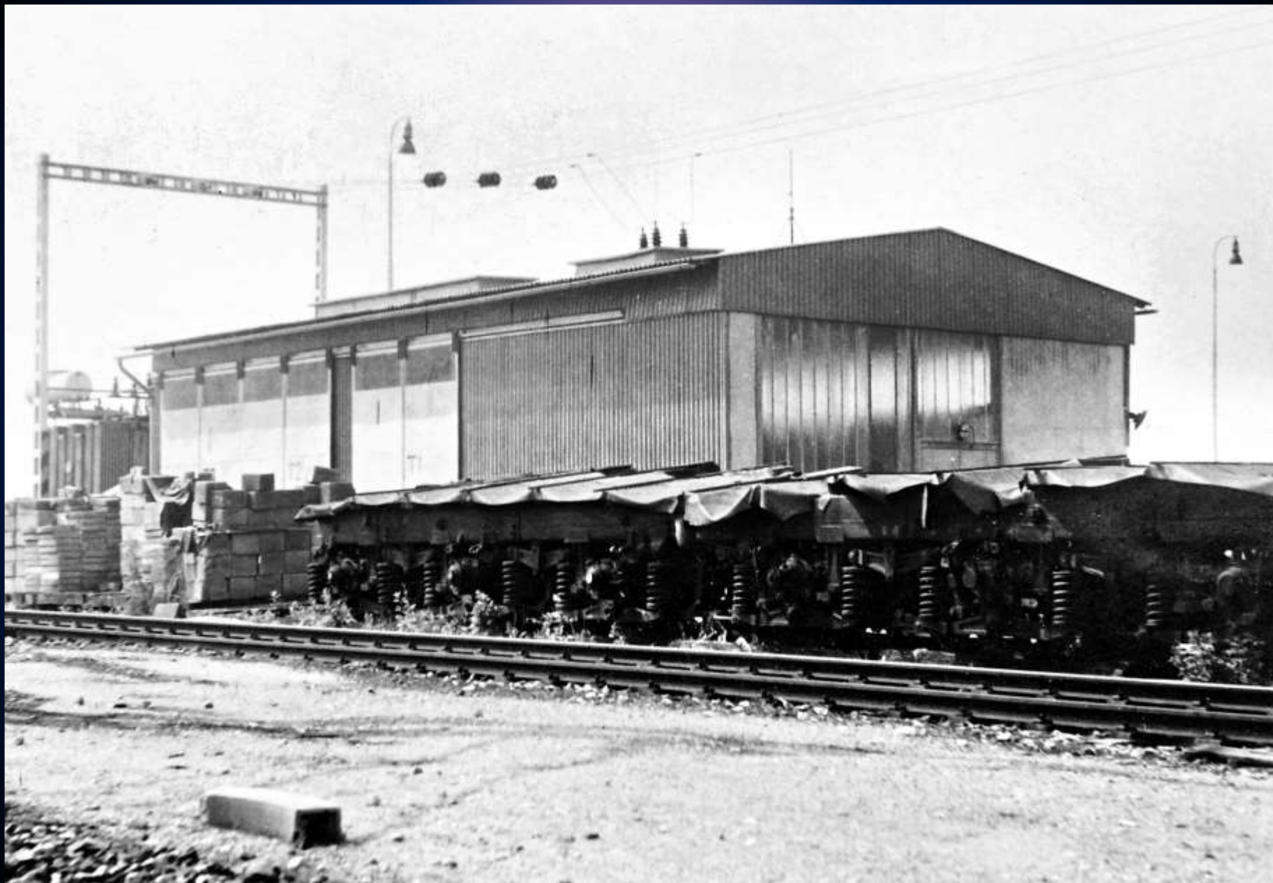
Původní podoba napájecí stanice ŽZO, v popředí podvozky lokomotivy S 699.001.
