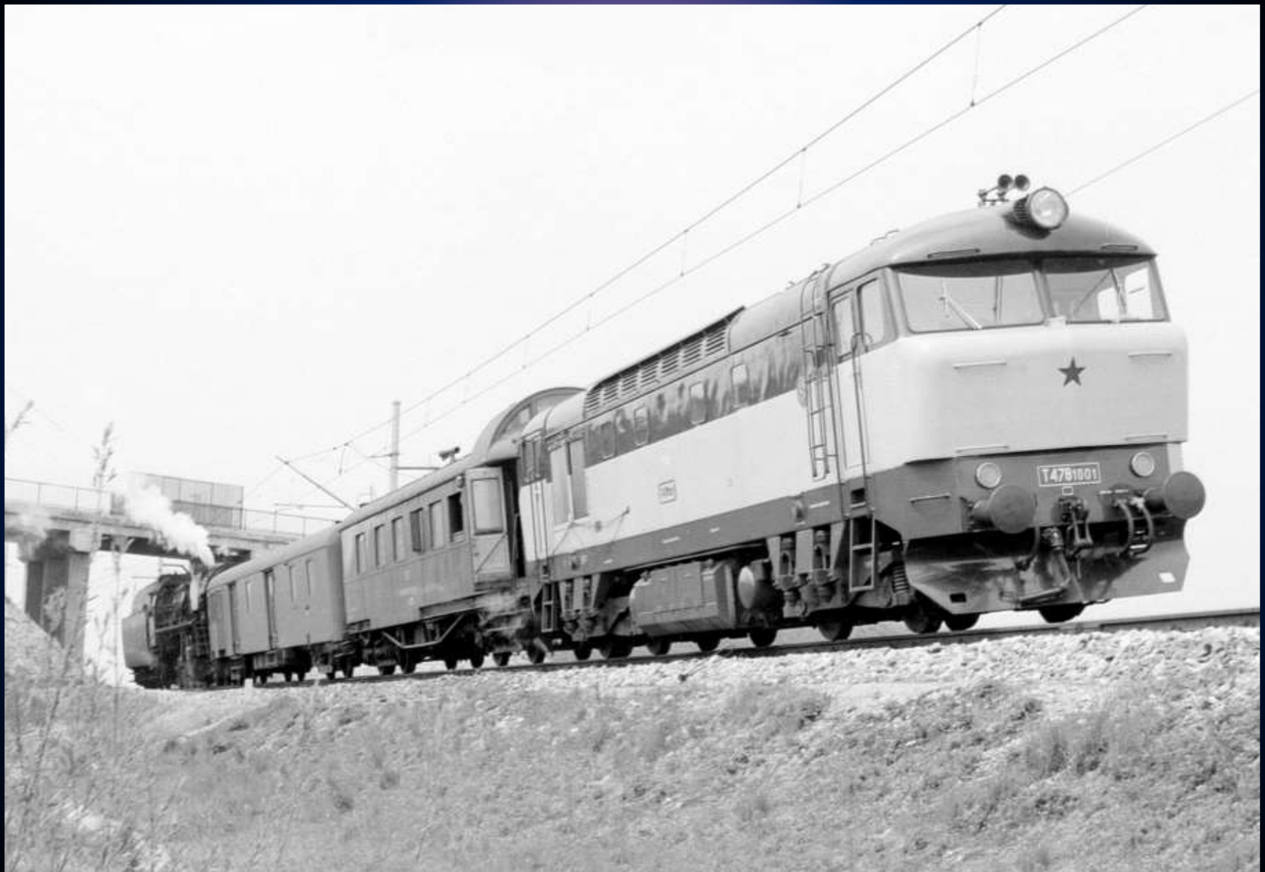
Na čerstvě zelektrizovaném velkém zkušebním okruhu se podrobuje trakčním zkouškám s dynamometrickým vozem prototypová lokomotiva T 478.1001.
