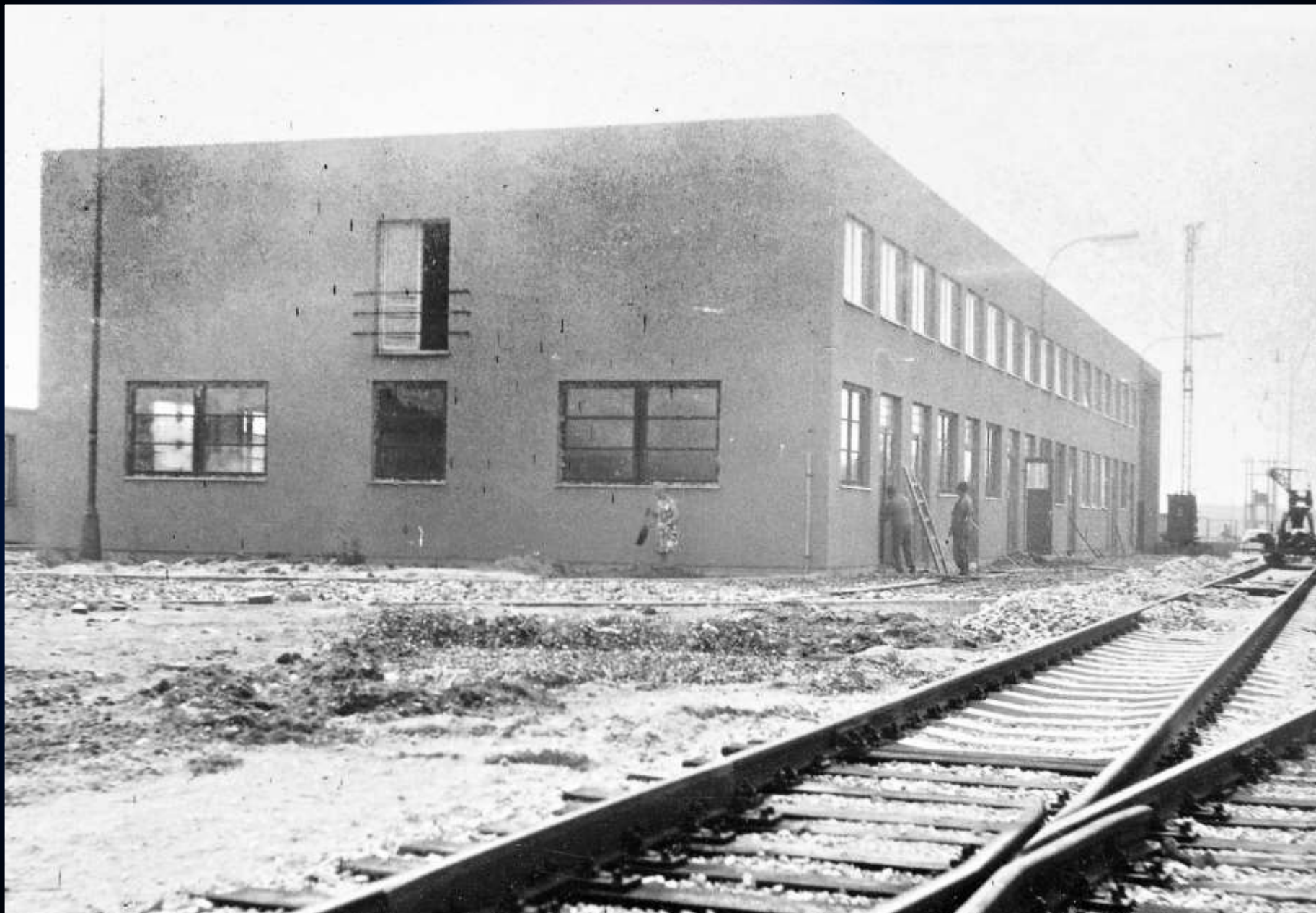
Stavba nové (současné) administrativní budovy ŽZO – pohled od dnešní haly HPZ IV.
