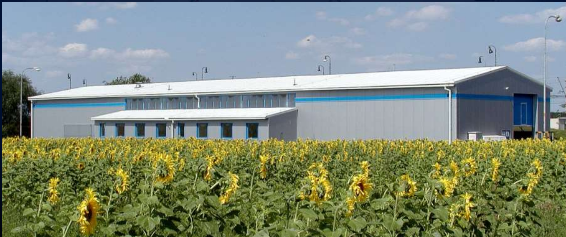
Hala HPZ I po první fázi výstavby – pohled směrem od Cerhenic.
