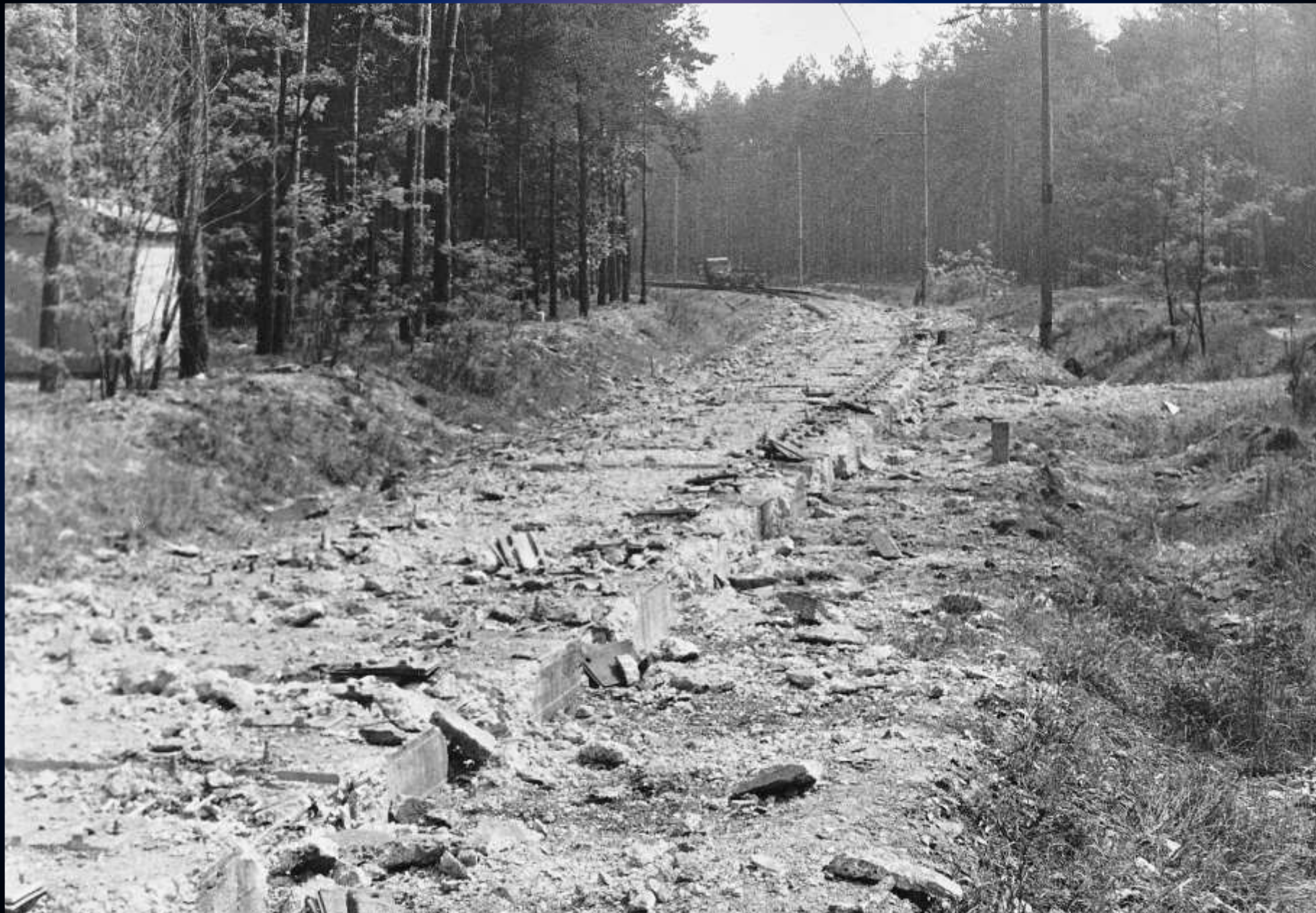
Snímek z léta roku 1976 zachycuje BR desku jednoho ze zkušebních úseků na MZO po odstřelu před uvedením trati do „standardního stavu“.
