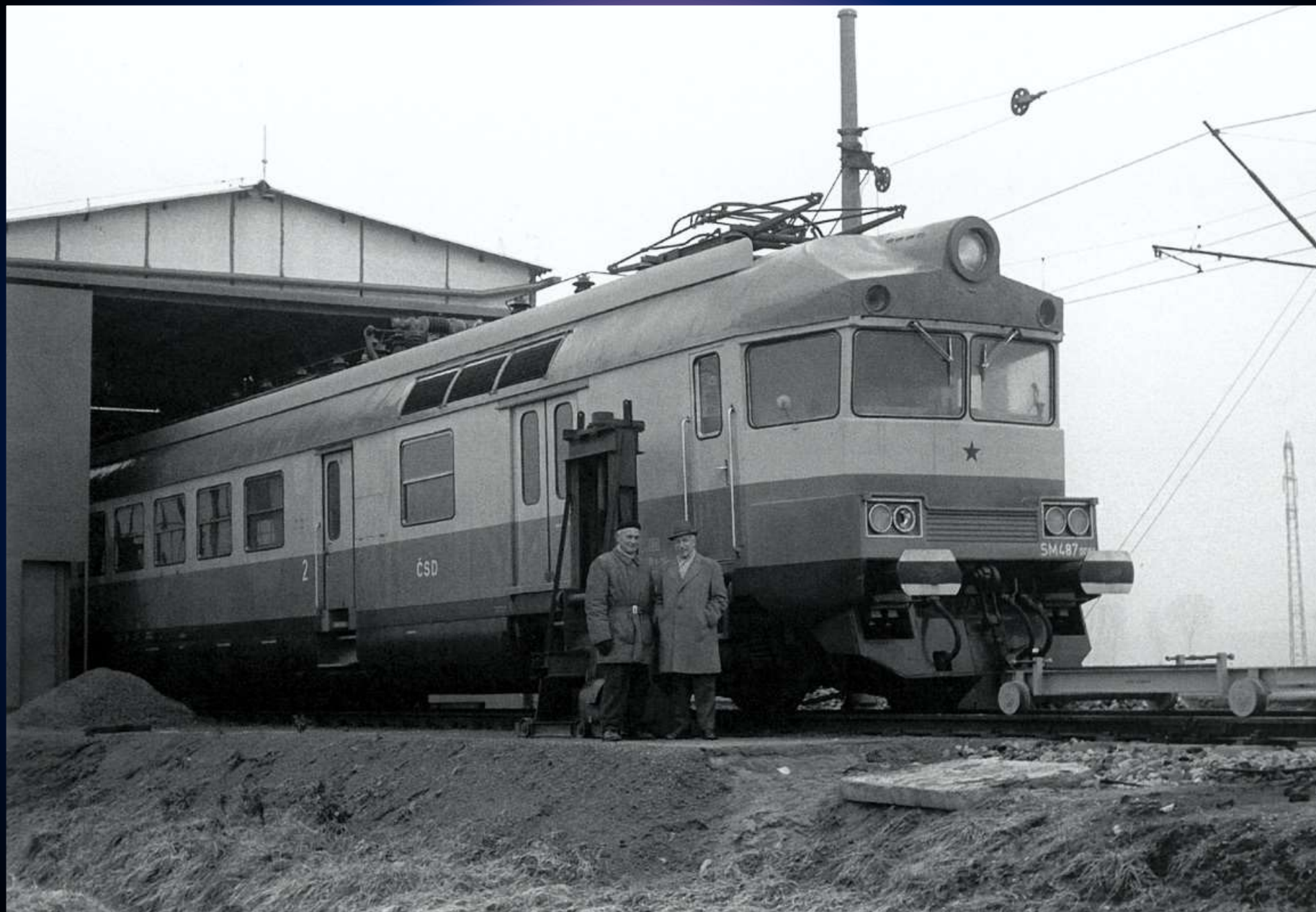
Bližší pohled na „starou halu“ s prototypem střídavé pantografické jednotky SM 487.0 z roku 1966.
