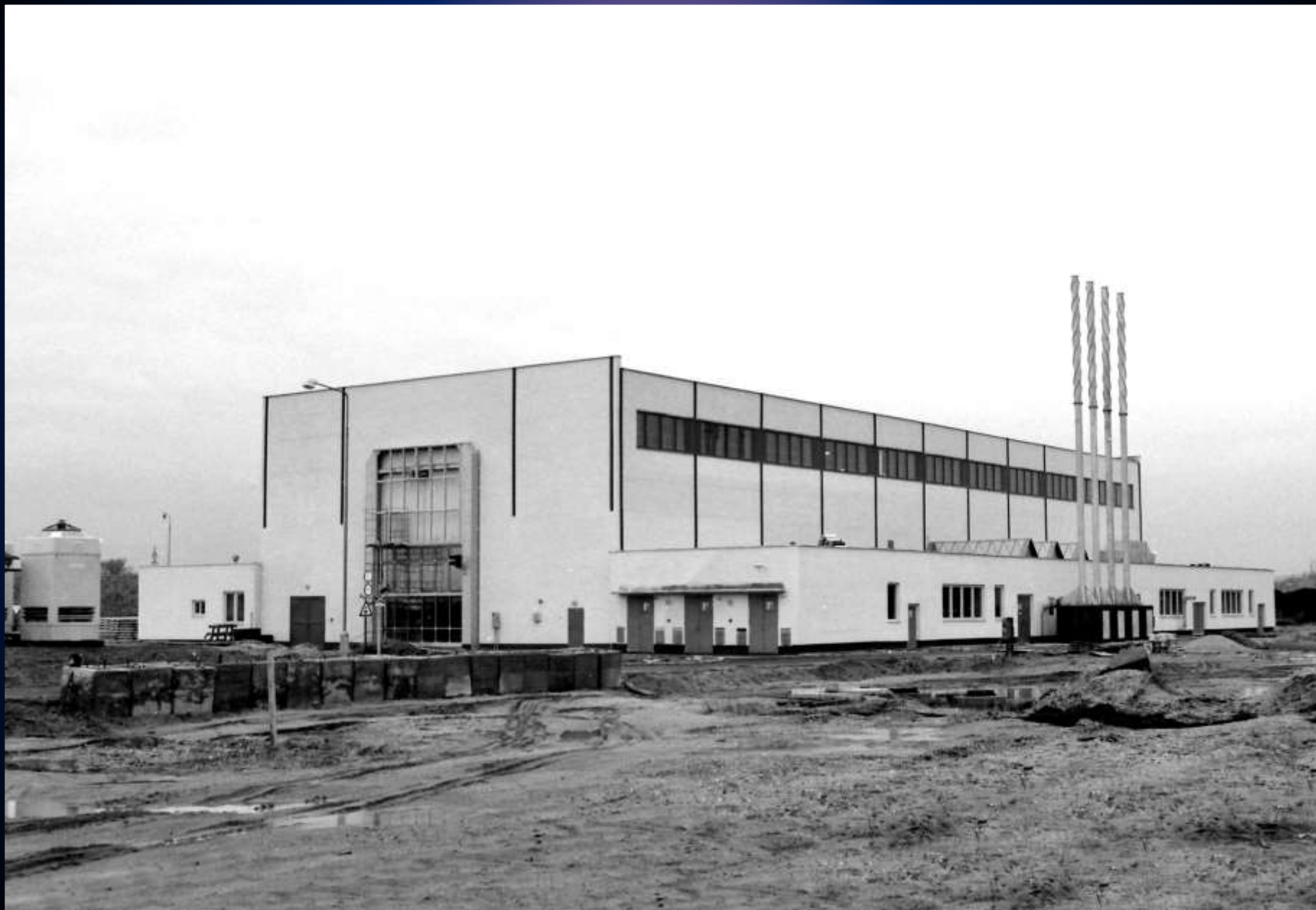
Čerstvě dokončená hala dynamické zkušebny.
