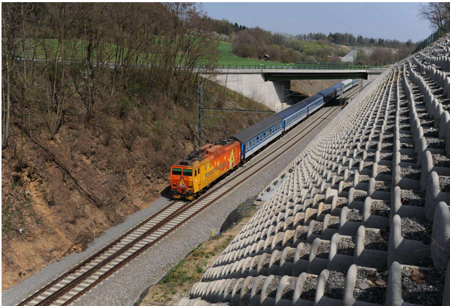
Zářez na modernizované trati
