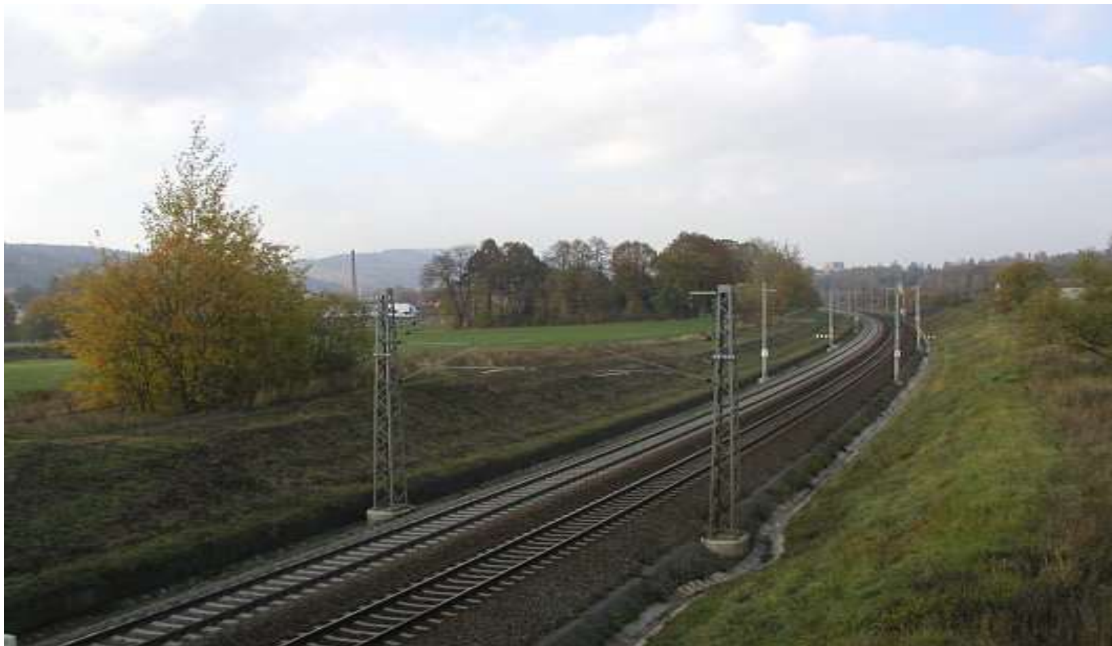
Oblouk před zastávkou Ústí nad Orlicí - město
