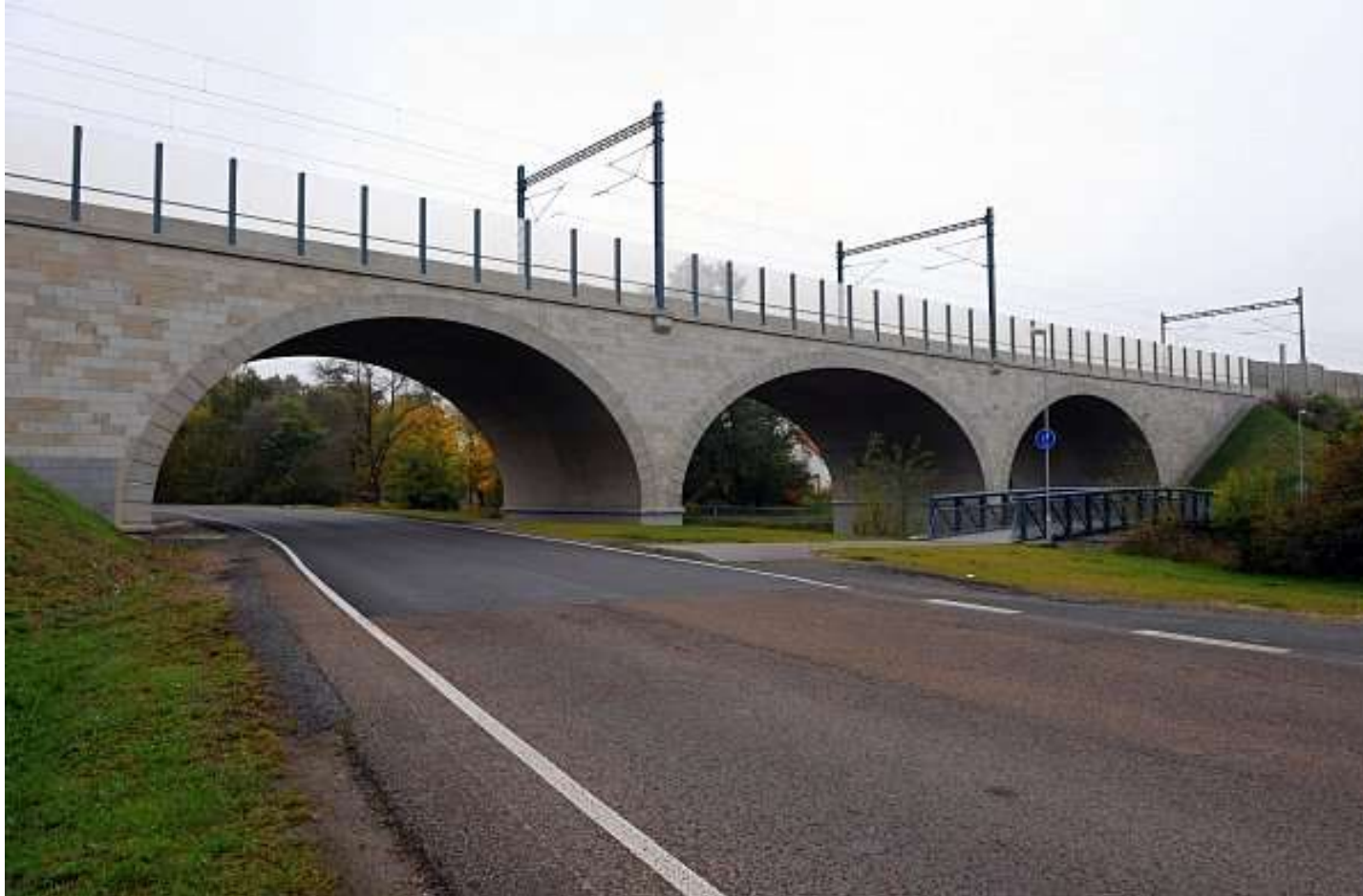
Železniční most přes silnici a řeku Klabavu v km 86,021 trati Praha Smíchov-Plzeň na okraji Rokycan
