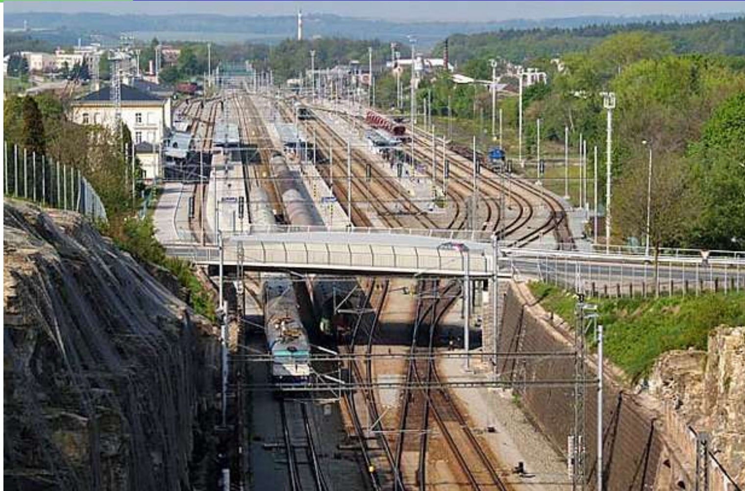
Pohled na modernizovaný uzel ze silničního nadjezdu
