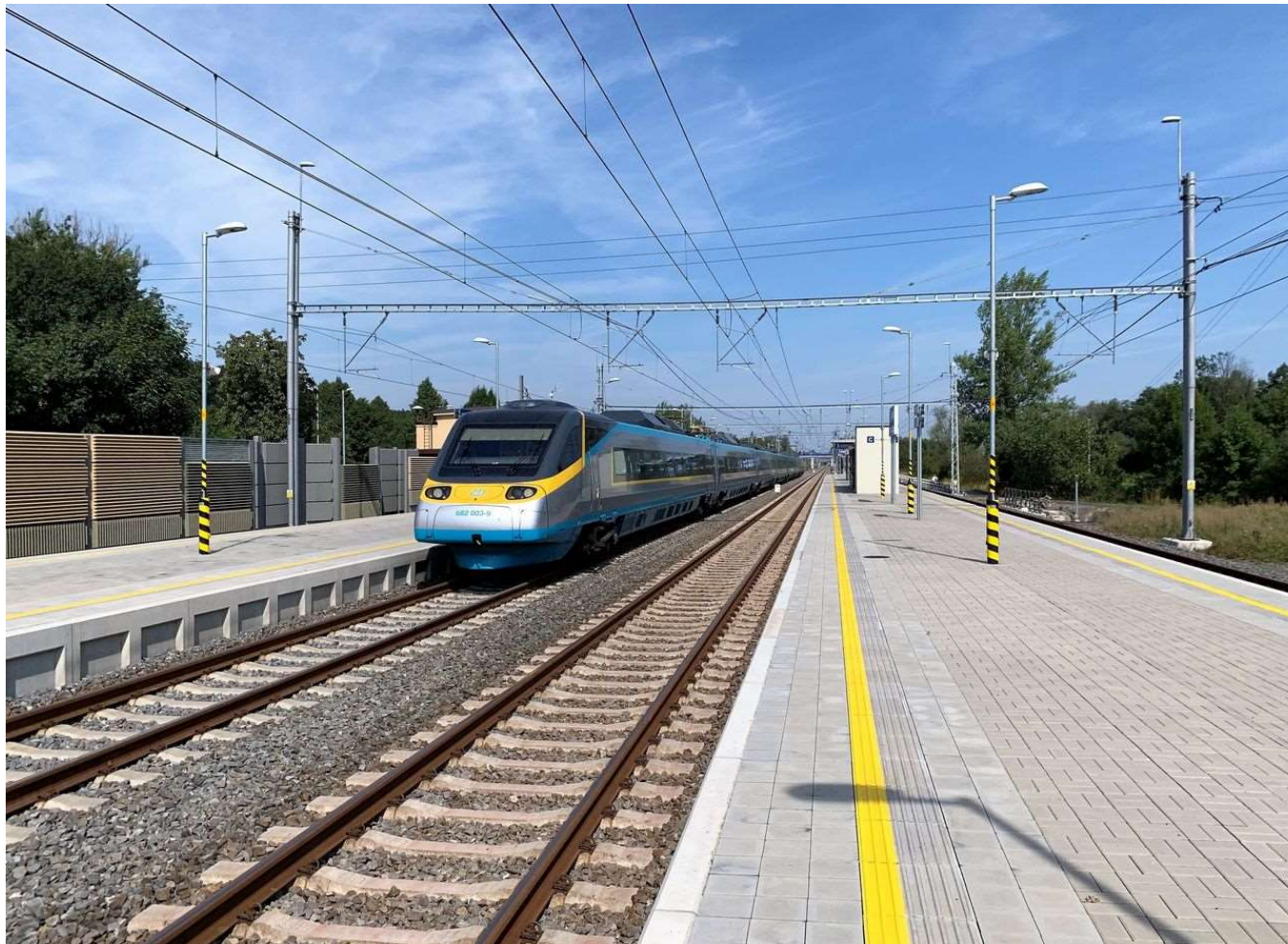
Pendolino na modernizované trati
