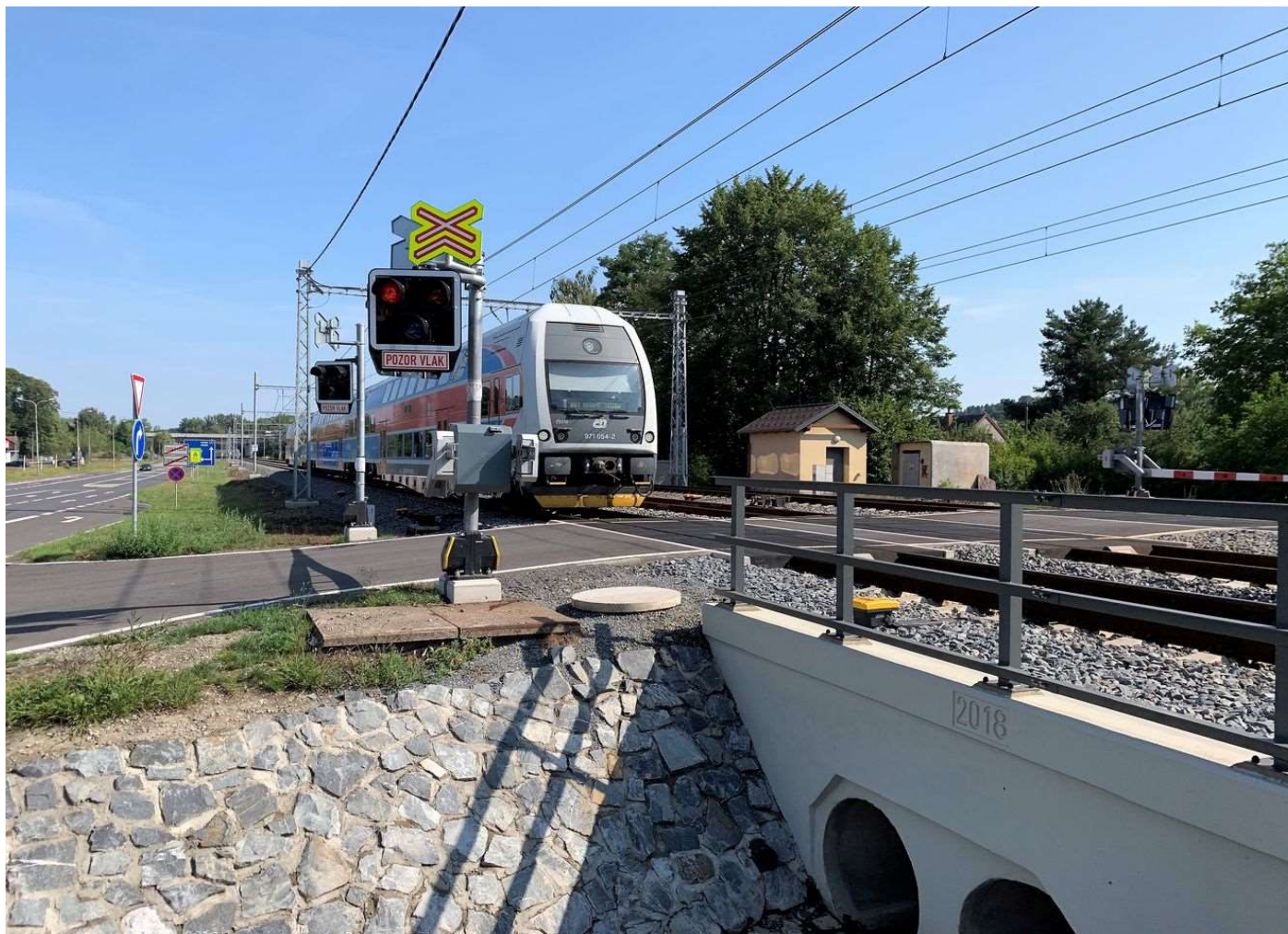
Modernizovaný železniční přejezd
