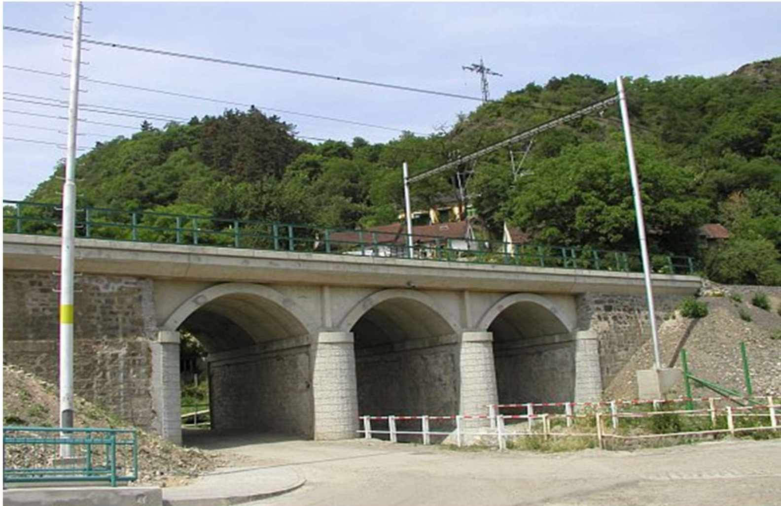
Modernizovaný železniční most
