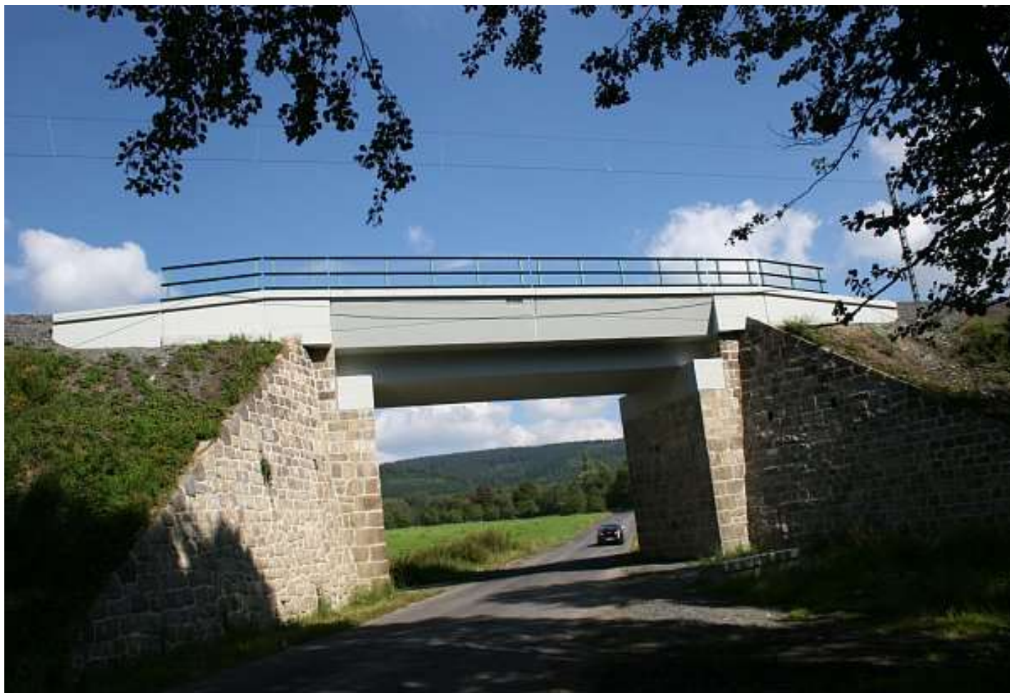
Rekonstruovaný železniční most
