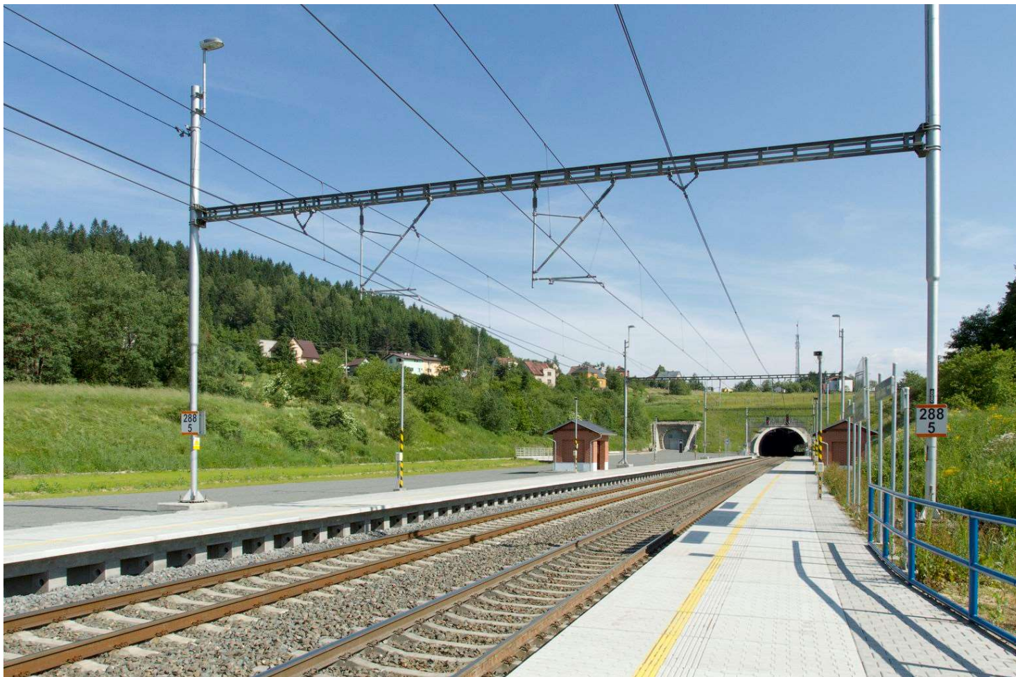
Zastávka Mosty u Jablunkova, v pozadí portál tunelu
