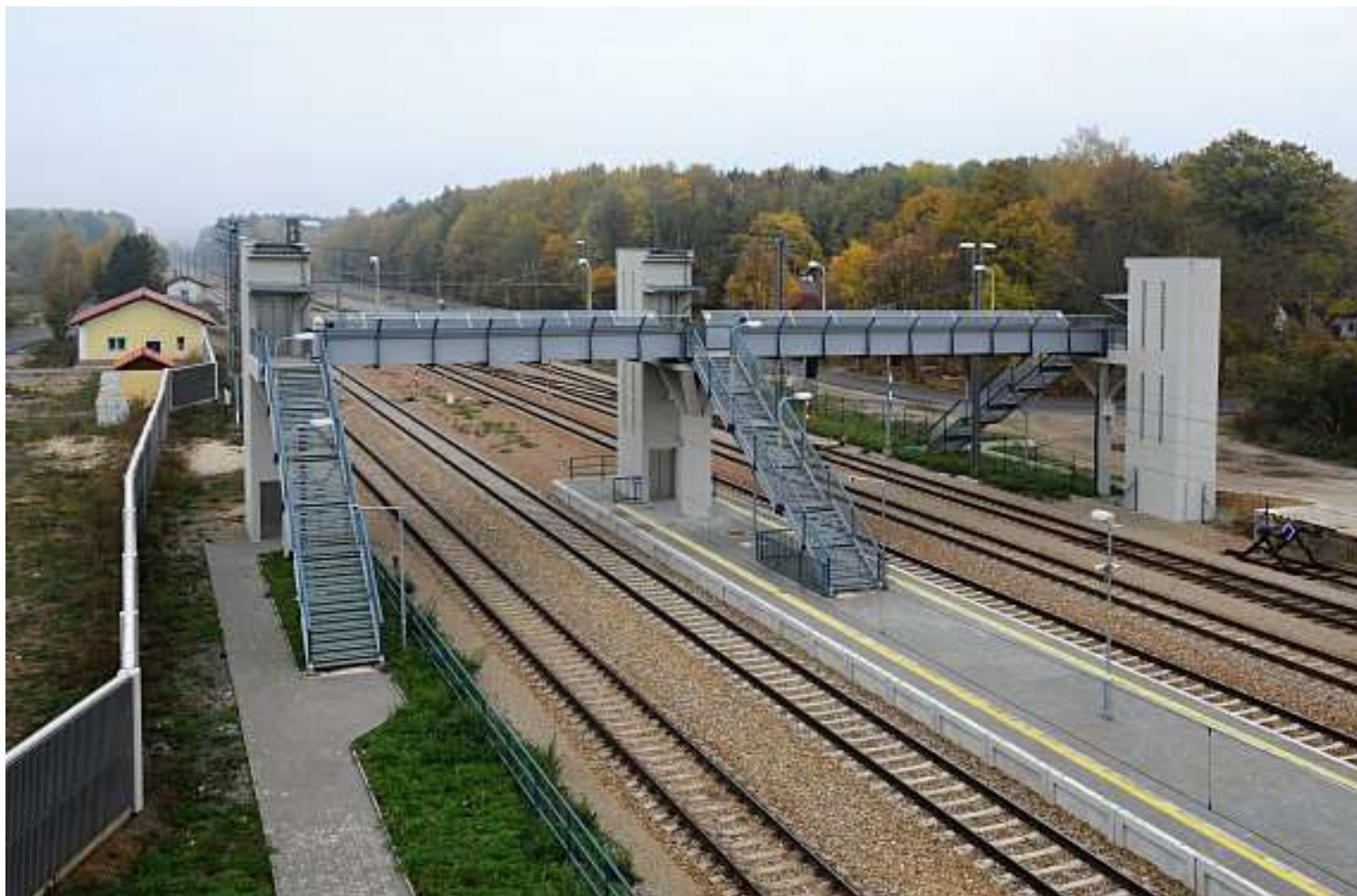
Lávka pro pěší v železniční stanici Kařízek v km 72,843
