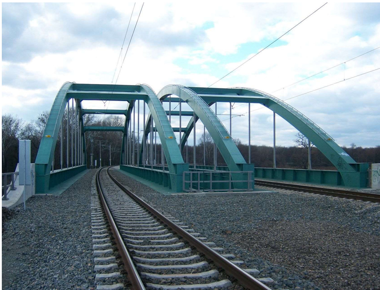
Traťový úsek Břeclav – Lanžhot , most v km 1,634
