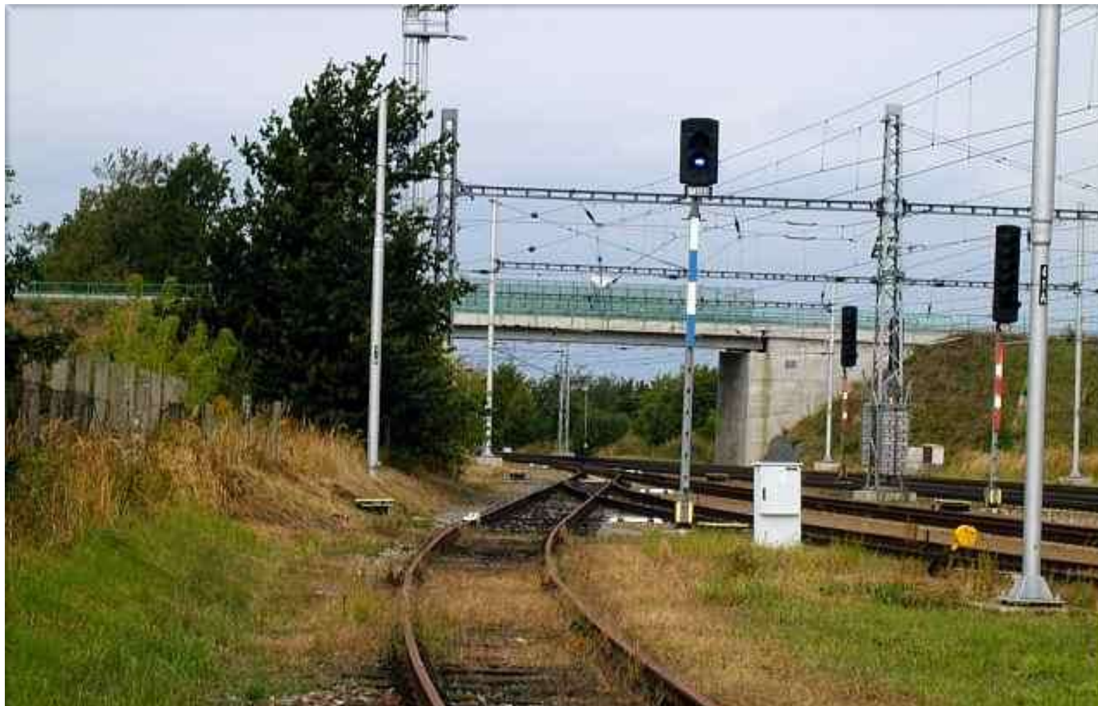
Silniční nadjezd ve stanici Kostějnice
