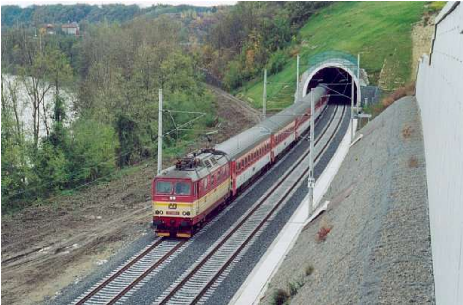
Tunel Vepřek, vlevo původní trať, vpravo mohutná opěrná zed'
