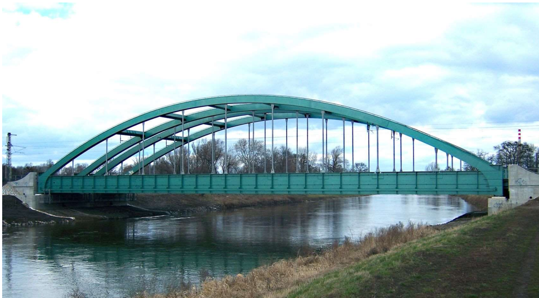
Traťový úsek Břeclav – Lanžhot , most v km 1,634
