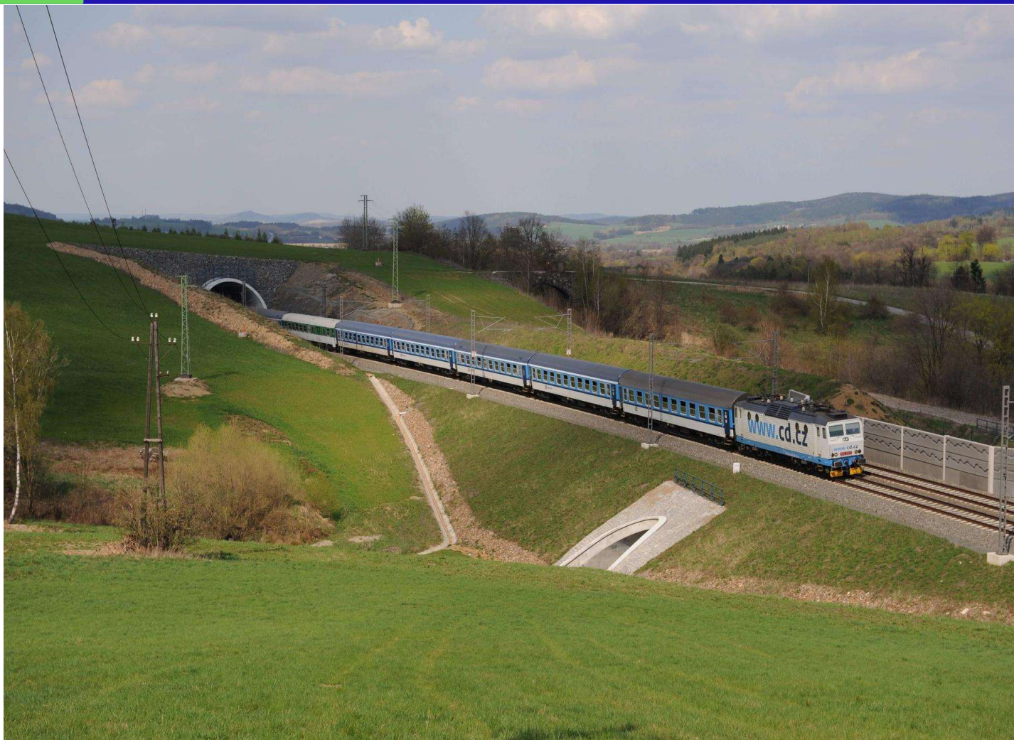
Jeden z tunelů na přeložce
