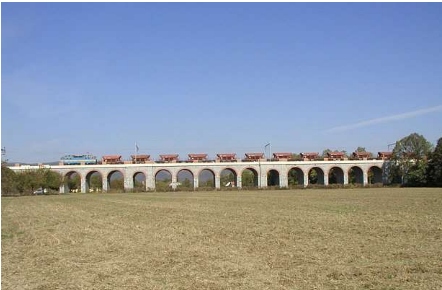
Jezernické viadukty, celkový pohled
