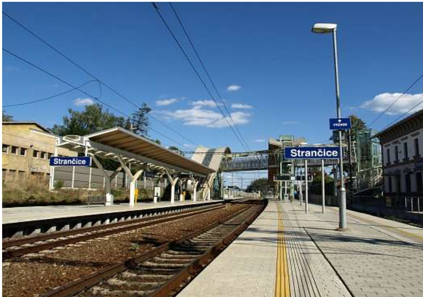
Stanice Stránčice s netradičně řešenou lávkou
