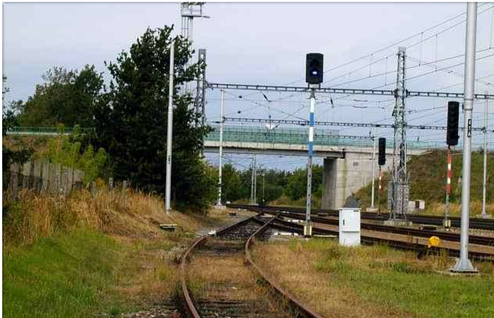
Silniční nadjezd ve stanici Kostějnice
