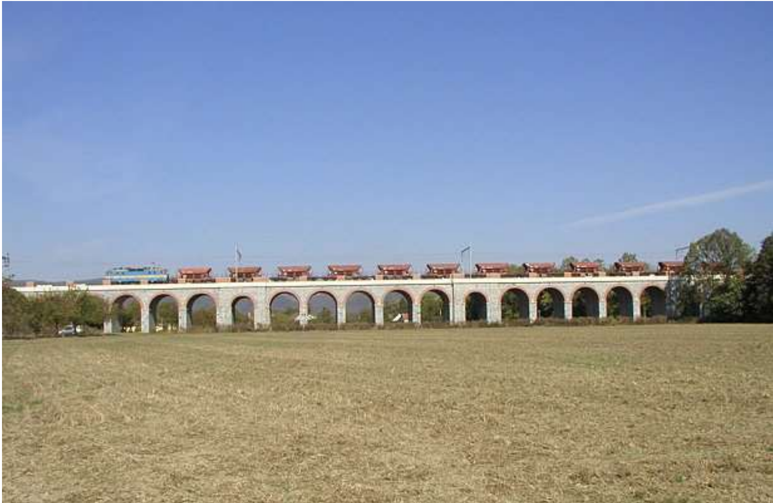
Jezernické viadukty, celkový pohled
