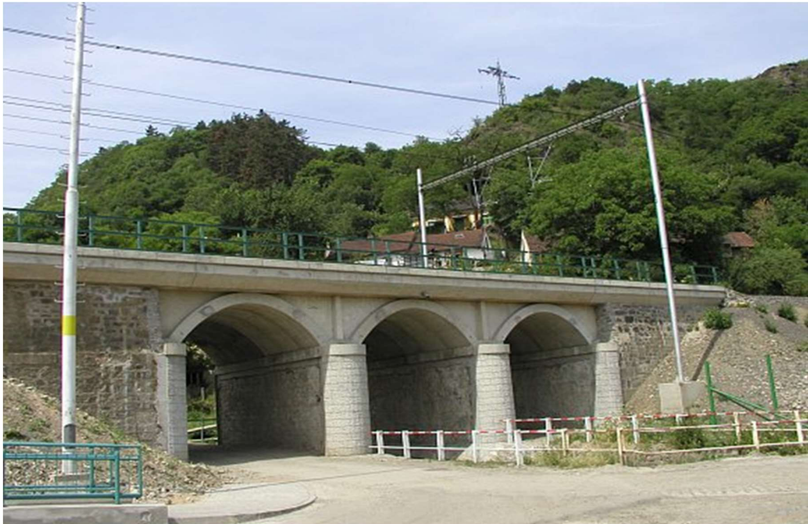
Modernizovaný železniční most
