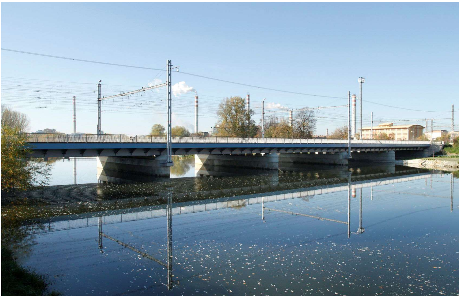
Žst. Přerov, železniční most přes Bečvu v km 183,974
