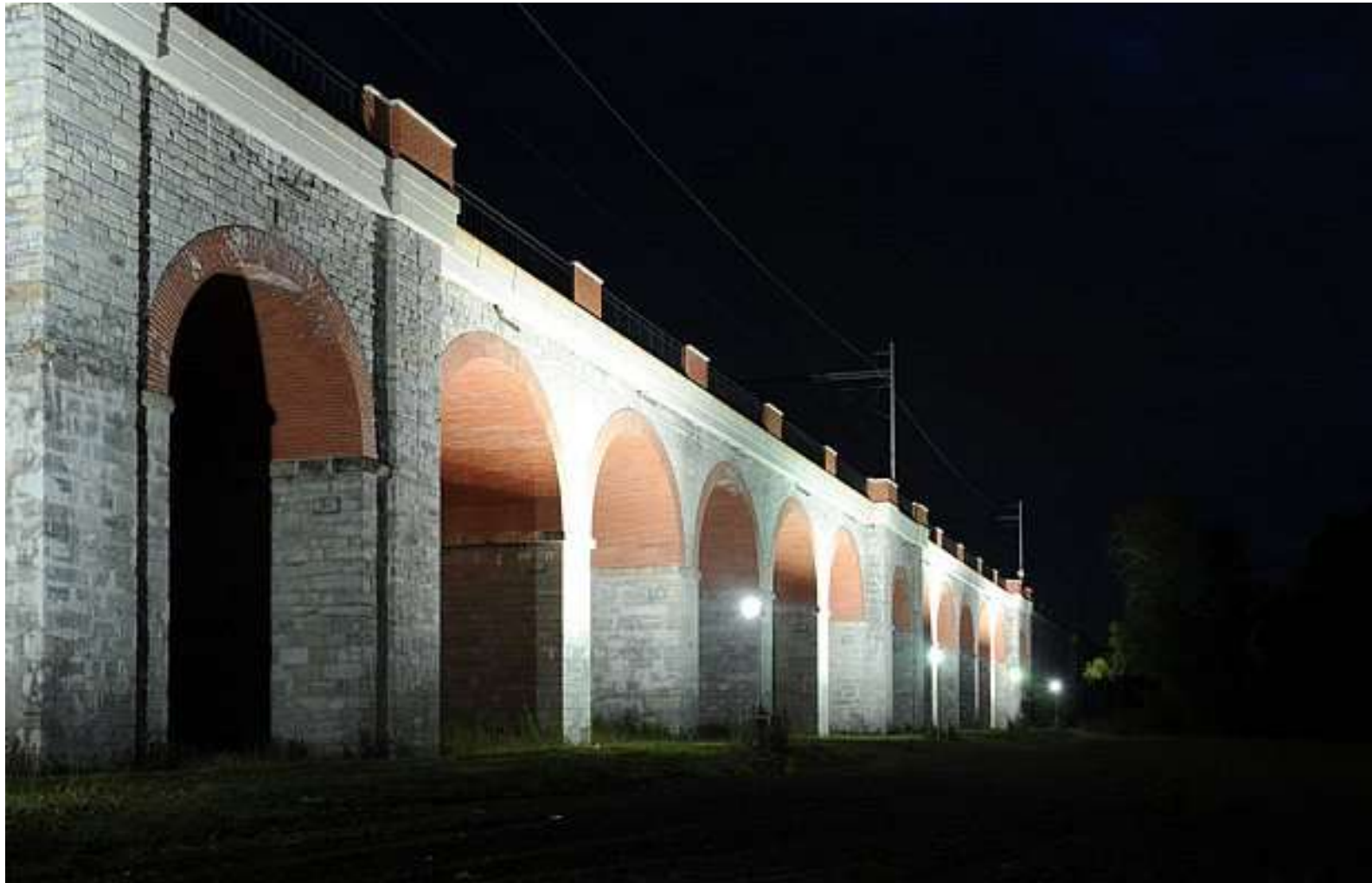
Jezernické viadukty, slavnostní osvětlení
