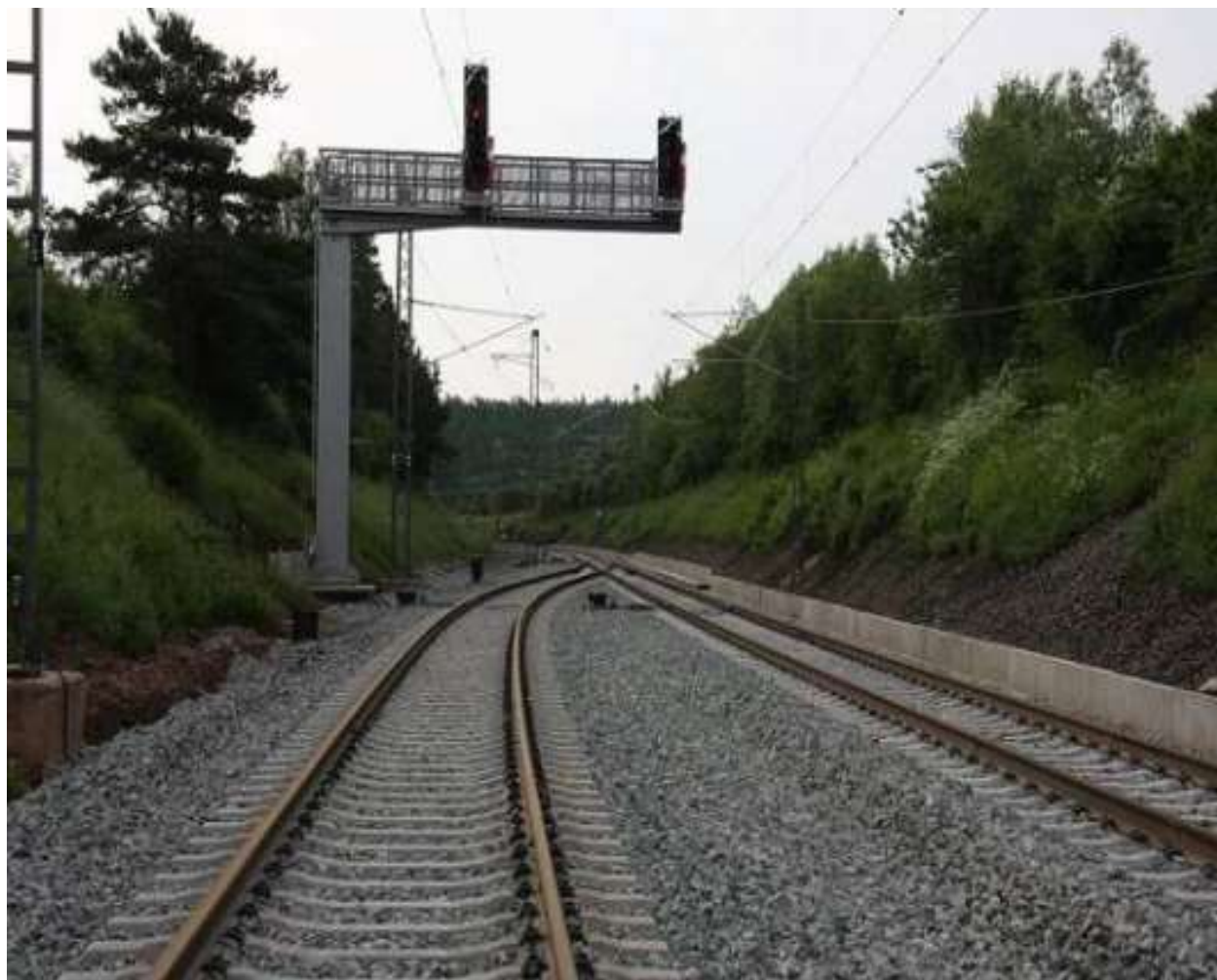
Stanice Vranov u Stříbra
