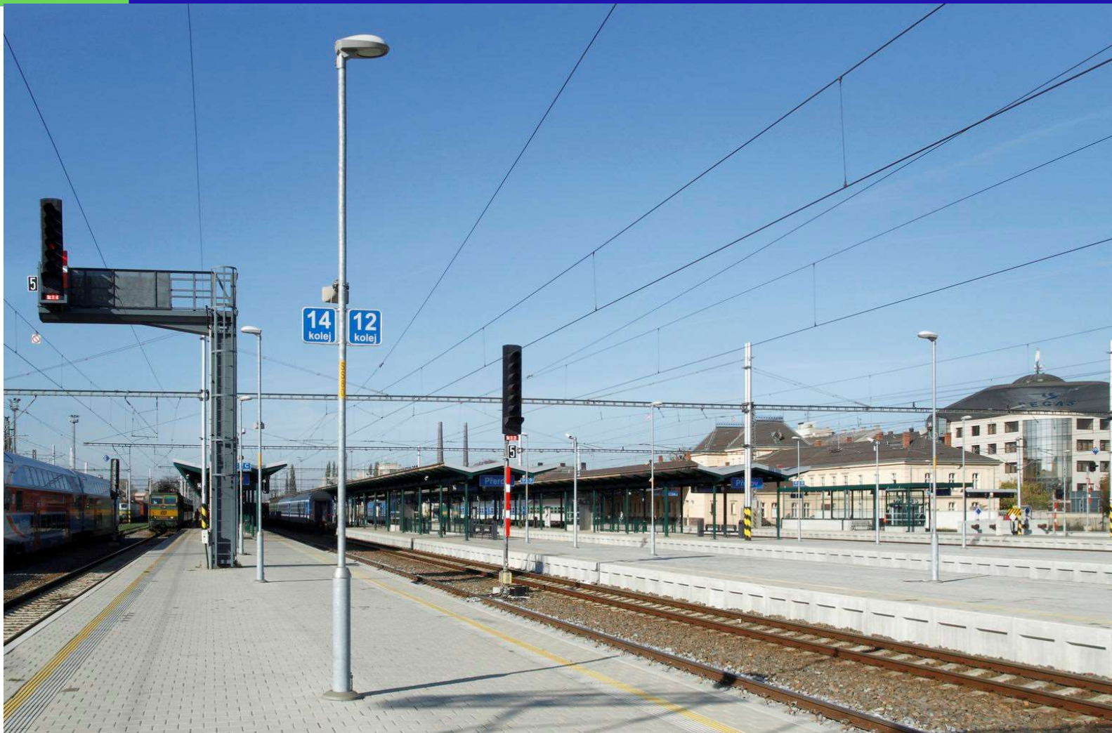
Ostrovní nástupiště v žst. Přerov
