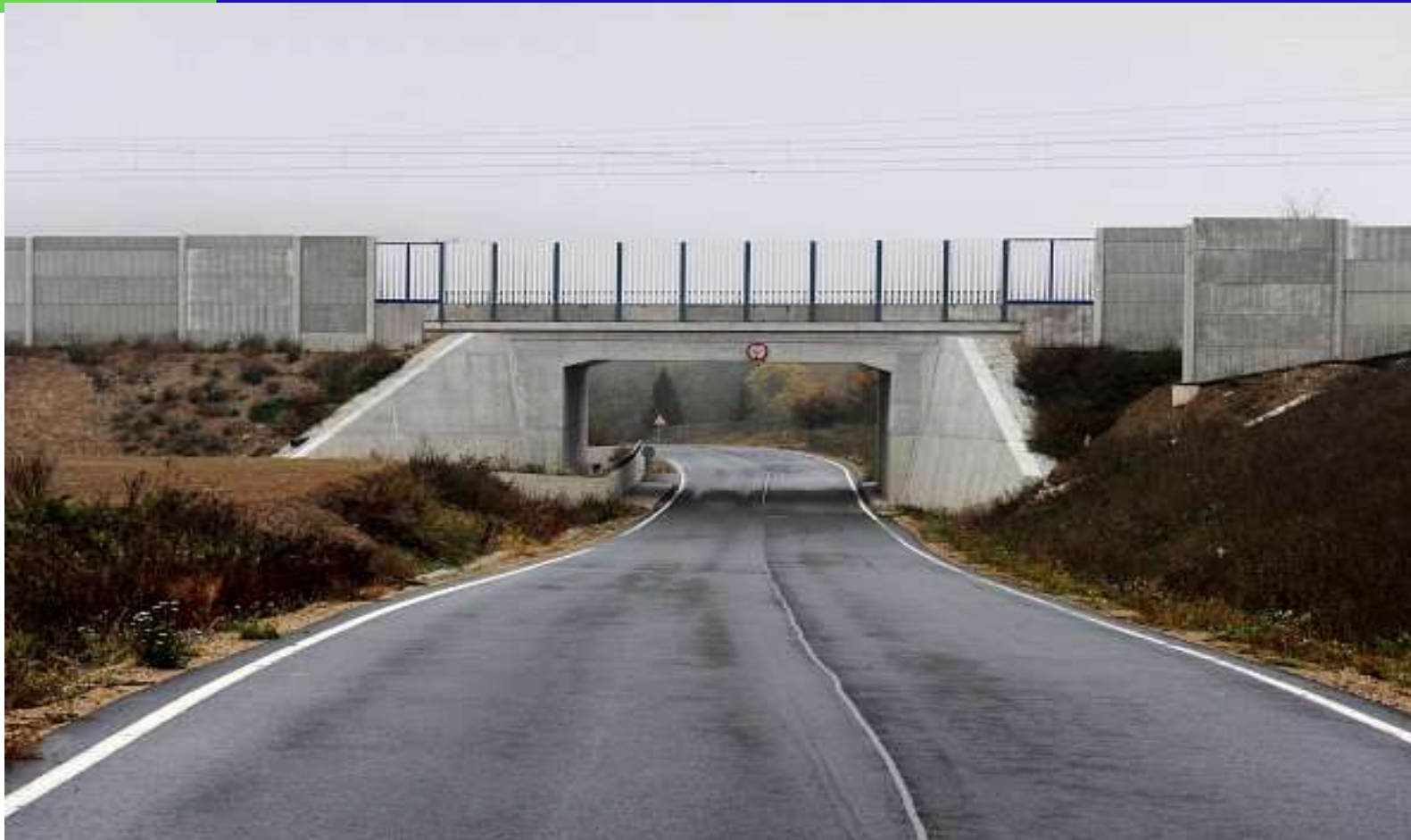
Železniční most přes silnici a Medoujezdský potok v km 76,621 u Medového Újezdu
