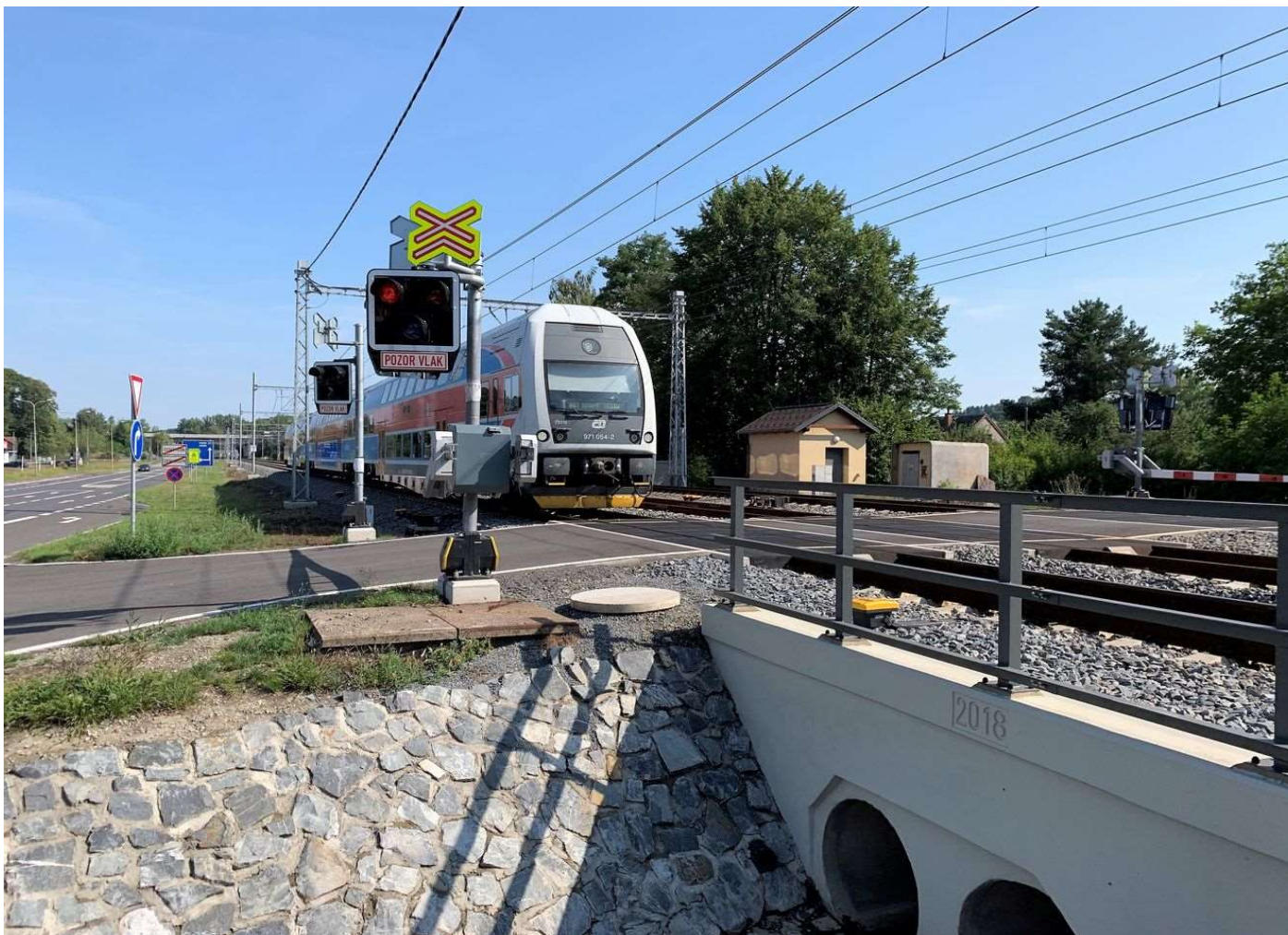
Modernizovaný železniční přejezd
