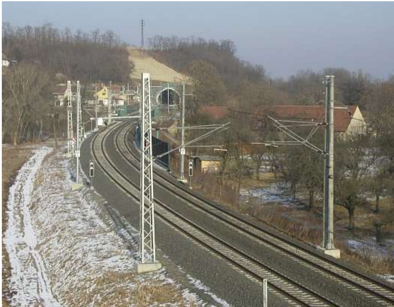
Tunel Vepřek, nelahozeveský portál, vpravo stejnojmenná obec
