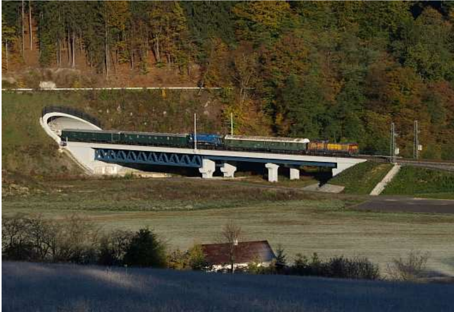
Most na přeložce
