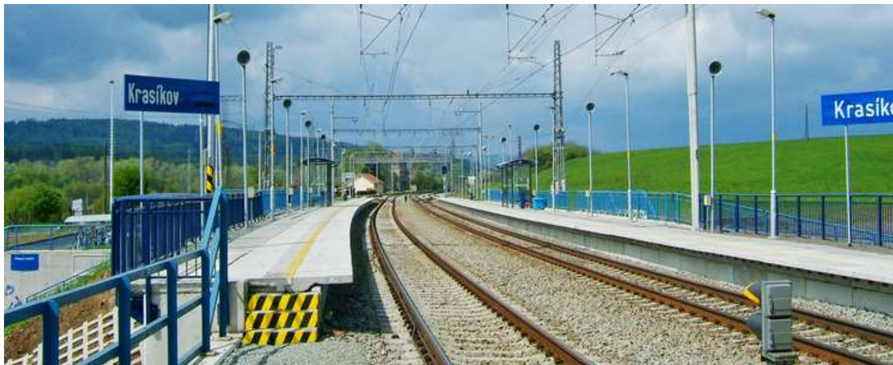
Zastávka Krasíkov, leží na zhlaví stanice
