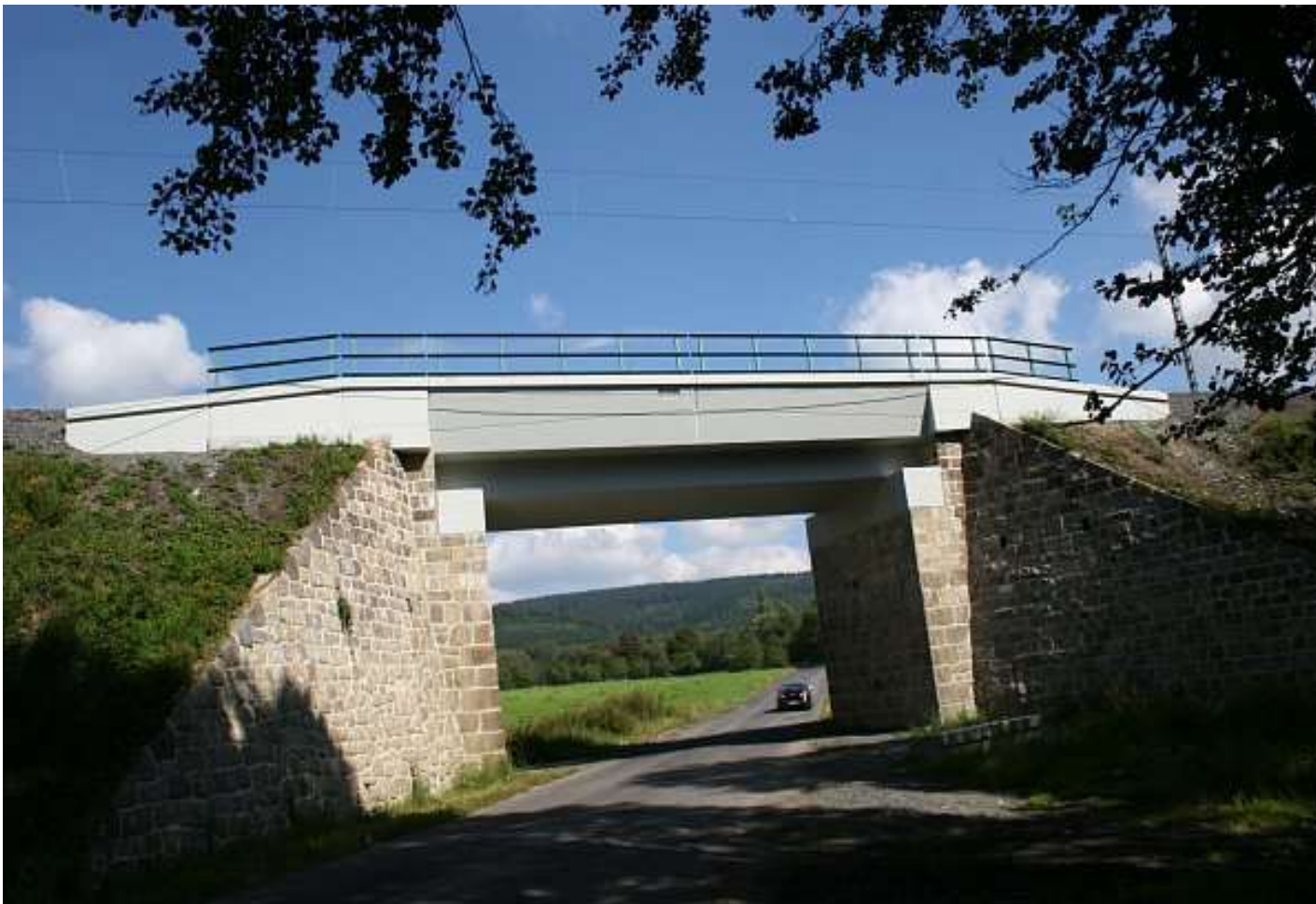
Rekonstruovaný železniční most
