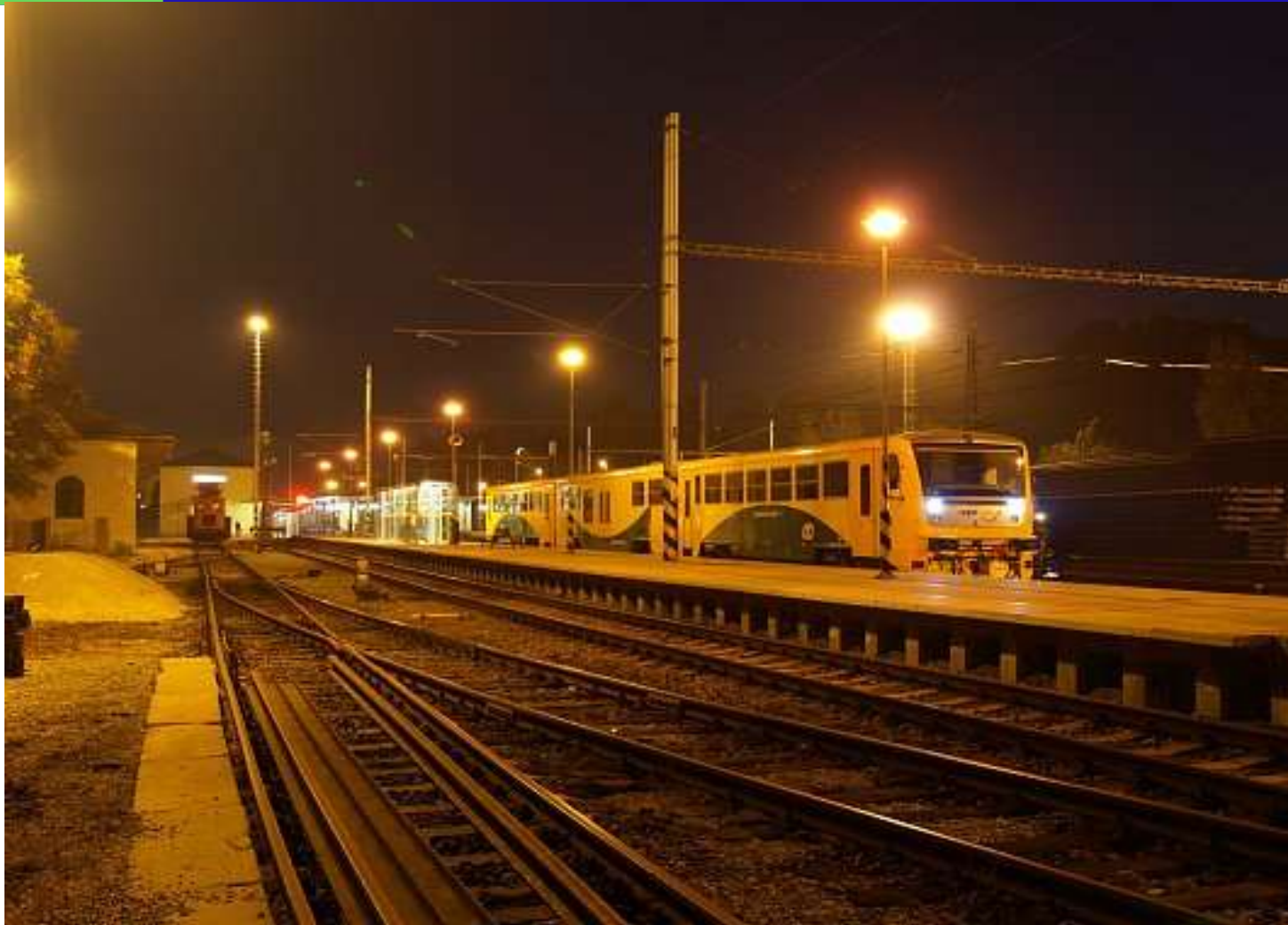
Stanice Zábřeh na Moravě
