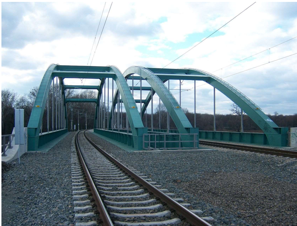
Traťový úsek Břeclav – Lanžhot , most v km 1,634
