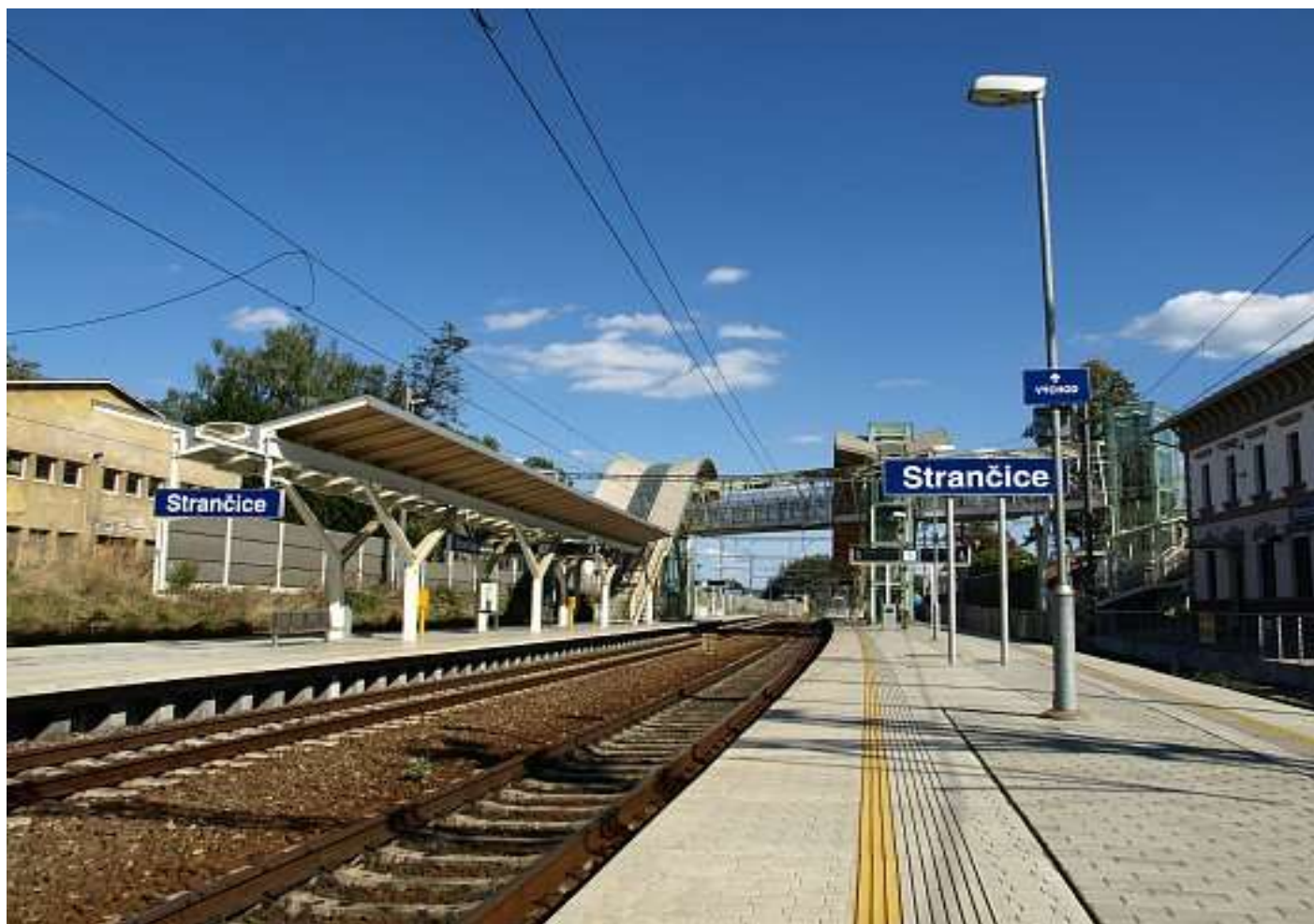
Stanice Stránčice s netradičně řešenou lávkou
