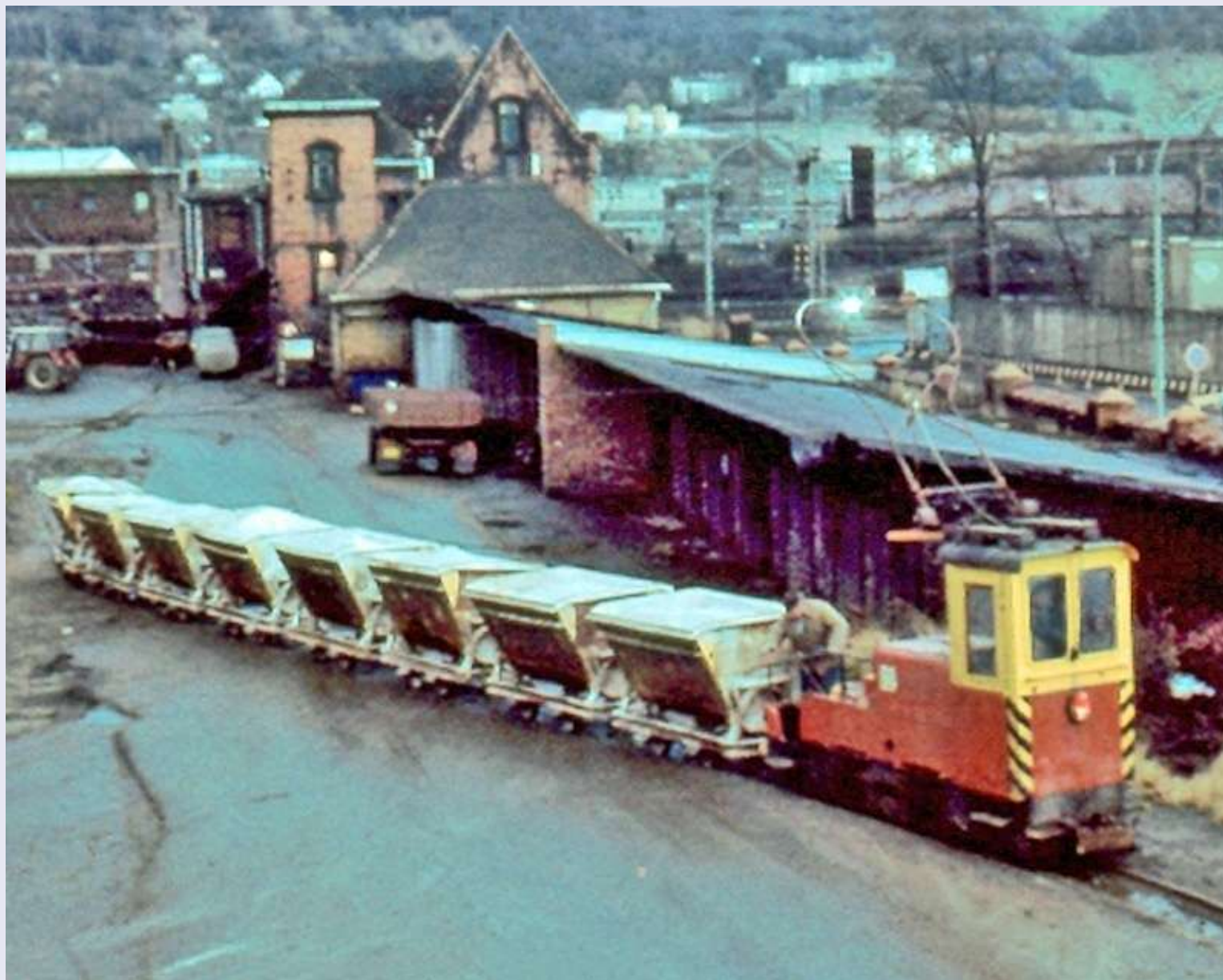
Lok TLP10 odváží odpadní sádku na výklopník, v pozadí objekt již neexistující staré západní vrátnice, asi prosinec 1987
