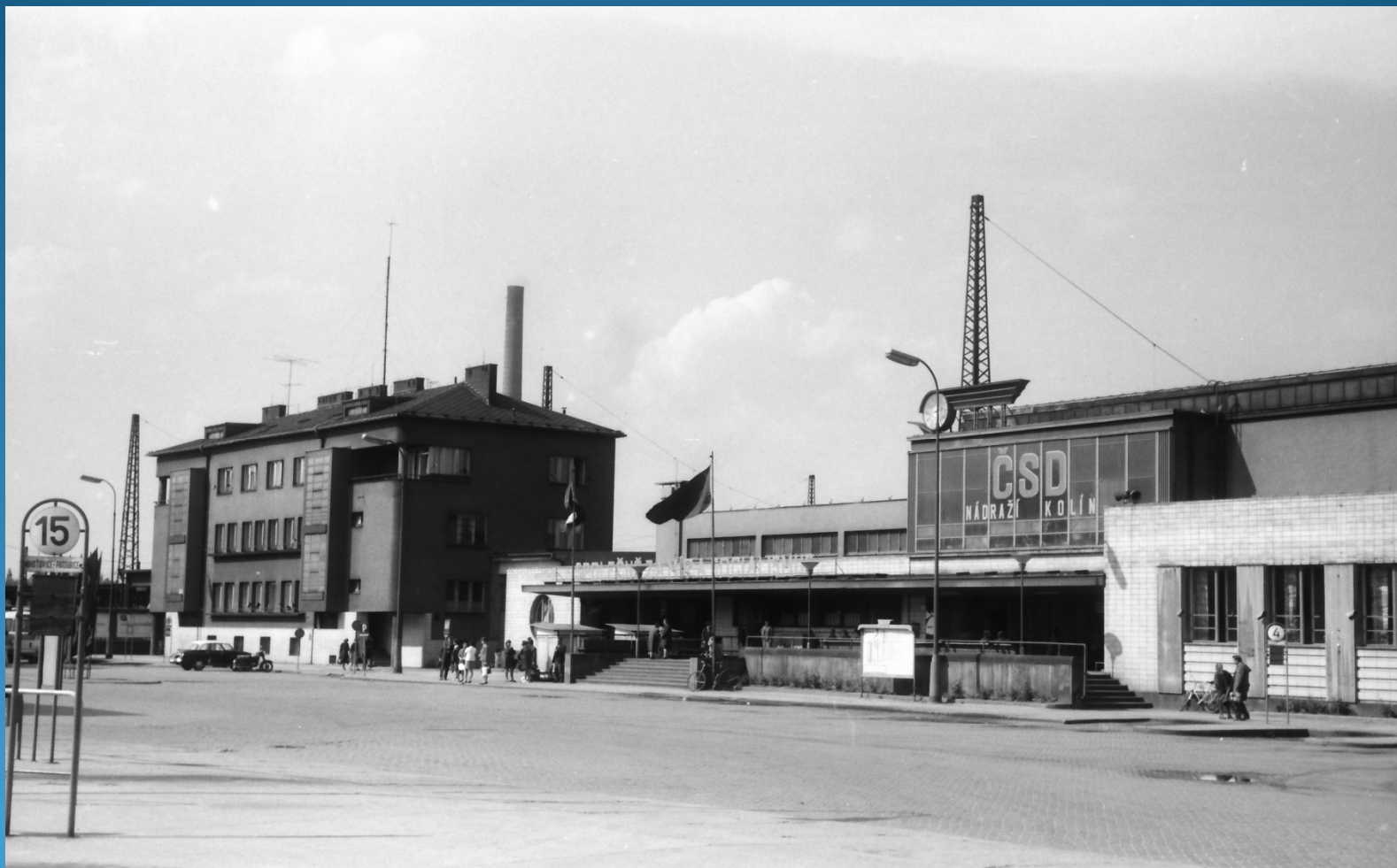
Výpravní budova žst. Kolín, 4.5.1968
